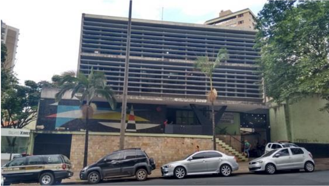
Figura 3 – Vista da fachada do Edifício do Antigo DOPS. Fonte: Fotografia do autor, 2015
