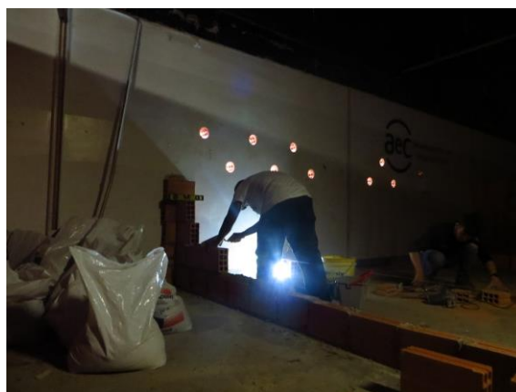
Figura 16: Construção do apartamento protótipo.
