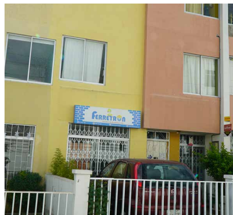
▼ Figura 15: Viviendas donde se han hecho tienditas en CB y Sociovivienda.
