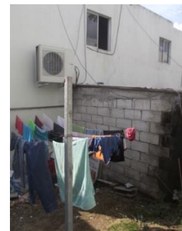
Figs 05 y 06 - Fachada del Fondo; en Modelo 4D, el patio de secado de ropas pertenece a la vivienda superior; el muro de bloques es la expansión de la vivienda de Paqui para conformación de más uno cuarto sin ventanas. El equipo de aire acondicionado en soporte fijado a la pared externa de la vivienda superior.
