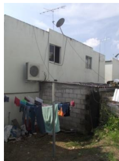
Figs 05 y 06 - Fachada del Fondo; en Modelo 4D, el patio de secado de ropas pertenece a la vivienda superior; el muro de bloques es la expansión de la vivienda de Paqui para conformación de más uno cuarto sin ventanas. El equipo de aire acondicionado en soporte fijado a la pared externa de la vivienda superior.
