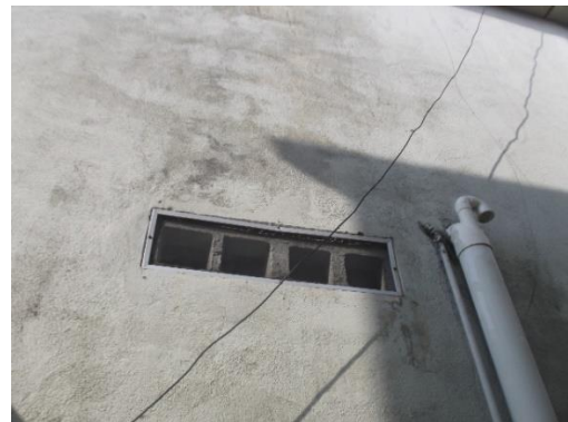
Fig. 13 – Elementos huecos de ventilación e iluminación del baño. Destacase el tubo de ventilación afijado en la fachada
