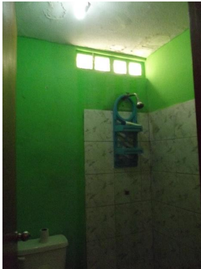
Figs. 10 y 11 Vista interna del baño, dotado de ducha y inodoro. Iluminación y ventilación son hechas por lo empleo de elementos huecos de hormigón. La bancada y lavatorio son externos en nicho ubicado entre el baño y la sala.
