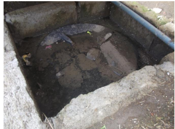
Figs. 13 y 14 – Tanque para recogida de aguas residuales: “eso está lleno, está lleno [...] yo hablé con el ingeniero que me ayude, que soy sola, que dependo de un pequeño negocio y me dice que ya no. Que no puede hacer nada. [...] Y me dice no ... usted tiene que darle mantenimiento. Por ay le estuve dando un poco de mantenimiento, pero [...] no va a rodar nunca, porque el agua corre”.
