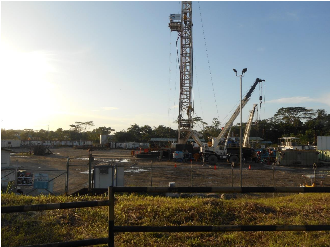
Figura N° 14. Pozo Lago Agrio 39 en un momento de desmontaje del taladro.
