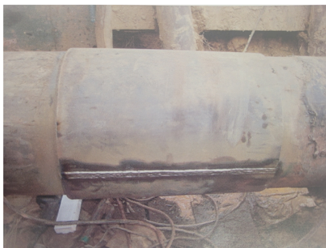
Figura 40 – Reparo por encamisamento
