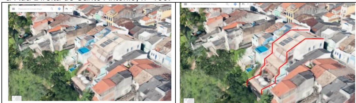
Figuras 9 e 10 – Vista da fachada posterior e da fachada lateral esquerda do imóvel à Rua Direita de Santo Antônio, nº 130.
