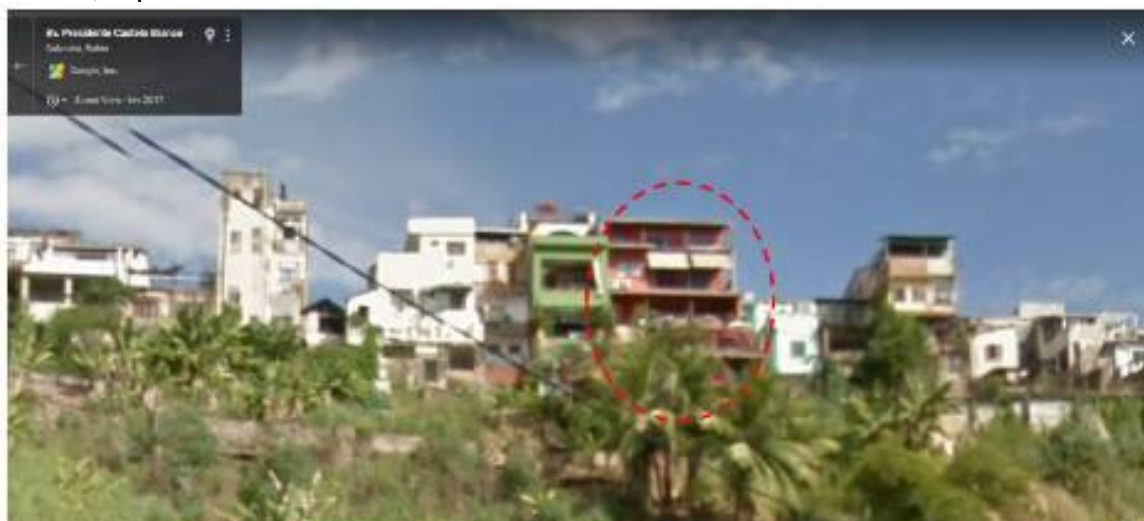
Figuras 11 – Vista da fachada posterior do imóvel à Rua Direita de Santo Antônio, nº 130, a partir da Baía de Todos os Santos.
