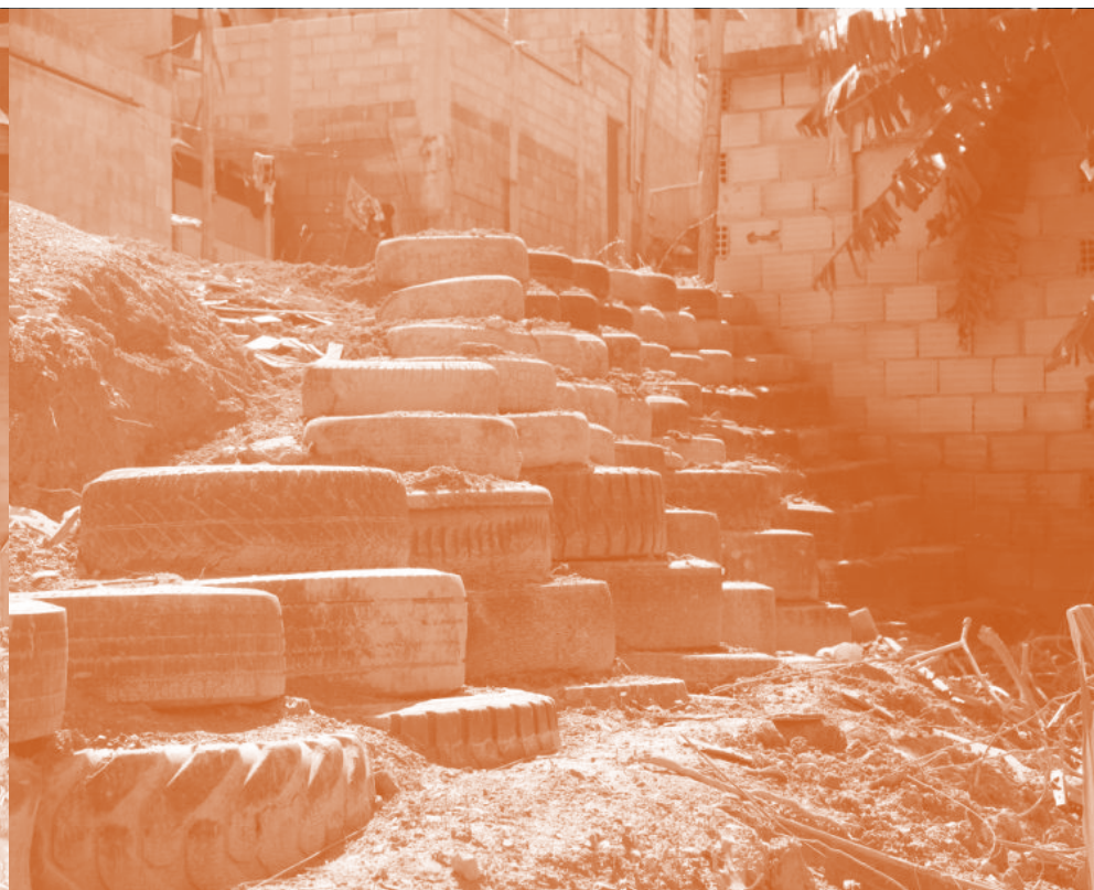
Contenção construída com pneus Fonte: Arquivo do Programa de Extensão Natureza Política.
