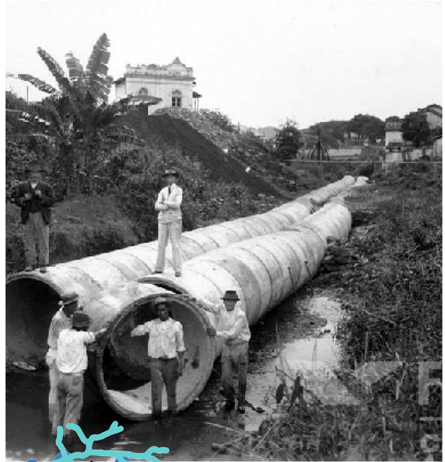
canalizaç o do C rrego da Serra na zona urbana de Belo Horizonte, em 1928 fonte: FGV/CPDOC o site curraidelrey.blogspot.com
