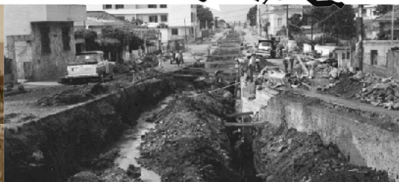
remoção da alvenaria de pedra para o alargamento da canalização e cobertura do Córrego do Acaba Mundo na Rua Professor Moraes, em 1963 fonte: APCBH/ASCOM disponível no site curraldelrey.blogspot.com
