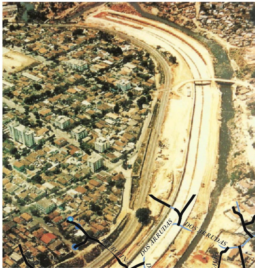
obras de retificação e canalização do Arrudas. à direita, o ribeirão desviado para um canal provisório, aterrado para o prolongamento da Avenida dos Andradas em 1986. à esquerda, o bairro de Santa Tereza.
