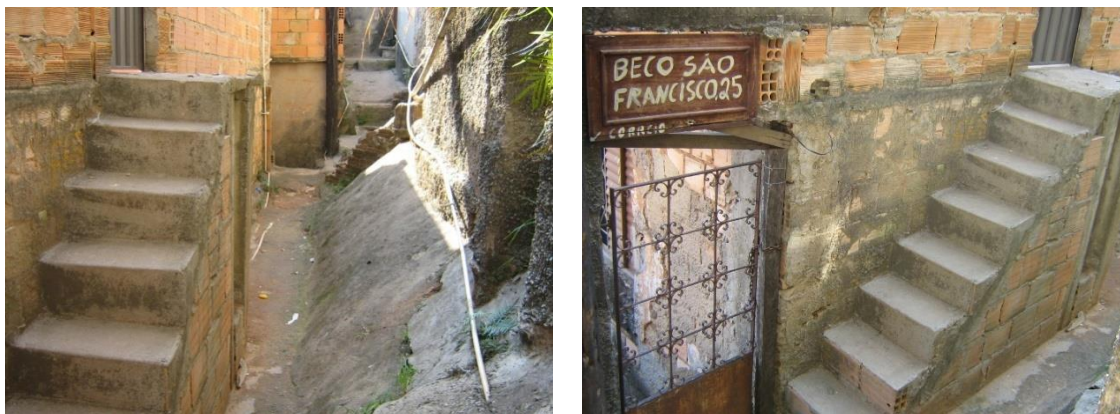
Figura 11 – Exemplo de construção em via pública (beco): escada.
