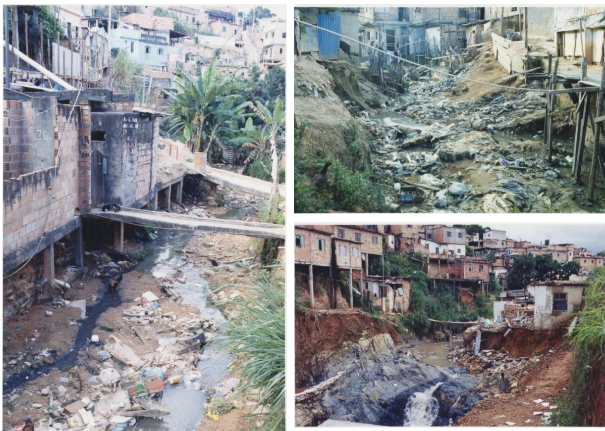
Figura 24 – Córrego Avaí na Vila Califórnia, antes das intervenções.
