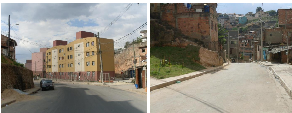
Figura 25 – Conjunto para reassentamento e Avenida Avaí, na Vila Califórnia.
