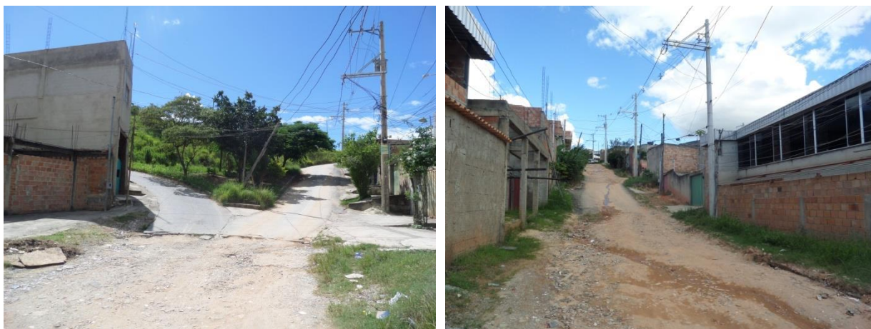
Figura 27 – Acesso do Bairro Maria Tereza e início da implantação da rede oficial de energia elétrica.
