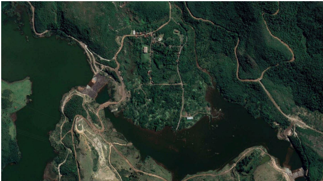
Figura 6 – Bento Rodrigues após a construção do dique S4
