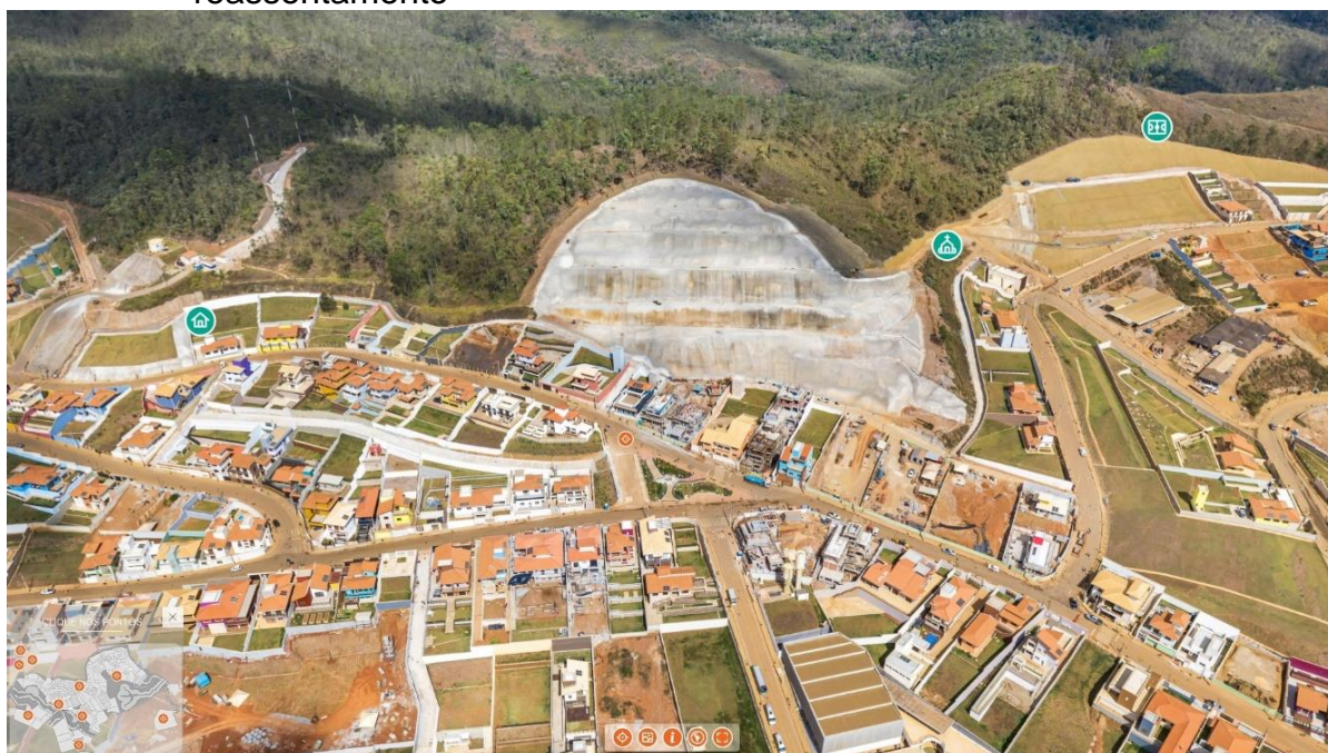
Figura 47 – Intervenção para contenção de encostas na parte mais alta do reassentamento
