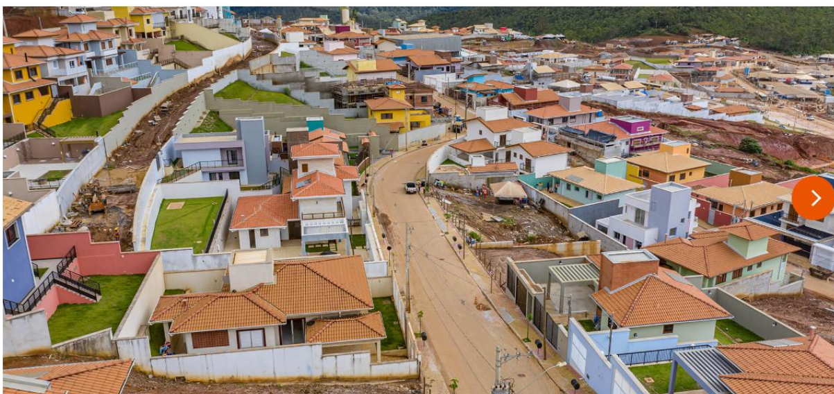
Figura 55 – Reassentamento de Bento Rodrigues - “O foco é a construção das casas”
