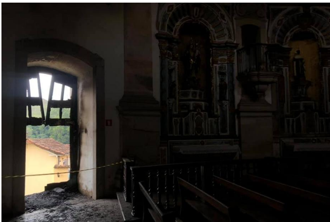
Figura 1 - Incêndio na Igreja do Rosário, Ouro Preto - MG. Fonte: fotografia de Lucas de Godoy, 2019.
