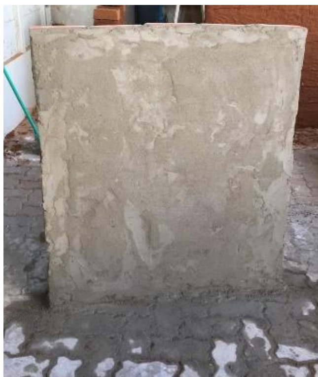
Figura 6 - Finalização da primeira camada de emboço, Conjunto II da Universidade Franciscana, Santa Maria – RS. Fonte: Acervo do acadêmico Alex Scherer Porporatti.
