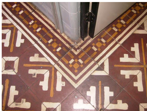
Detalhe de piso em ladrilho hidráulico da edificação.
