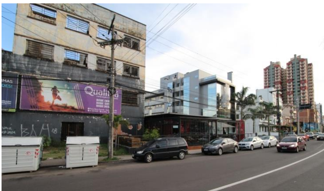
Figura 6 - O Moinho Antoniazzi (esquerda) contrastando com os edifícios recentes do entorno. Fonte: Acervo pessoal, 2019
