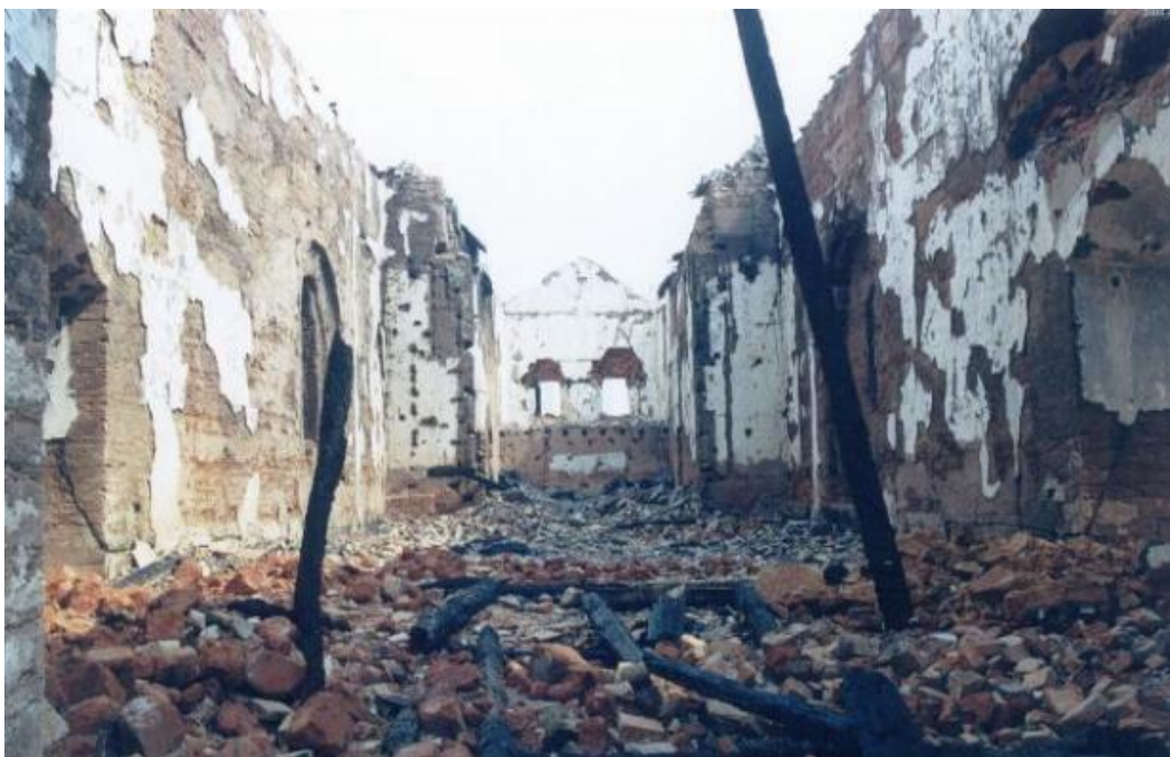
Figura 16 - Igreja após a destruição pelo incêndio.
