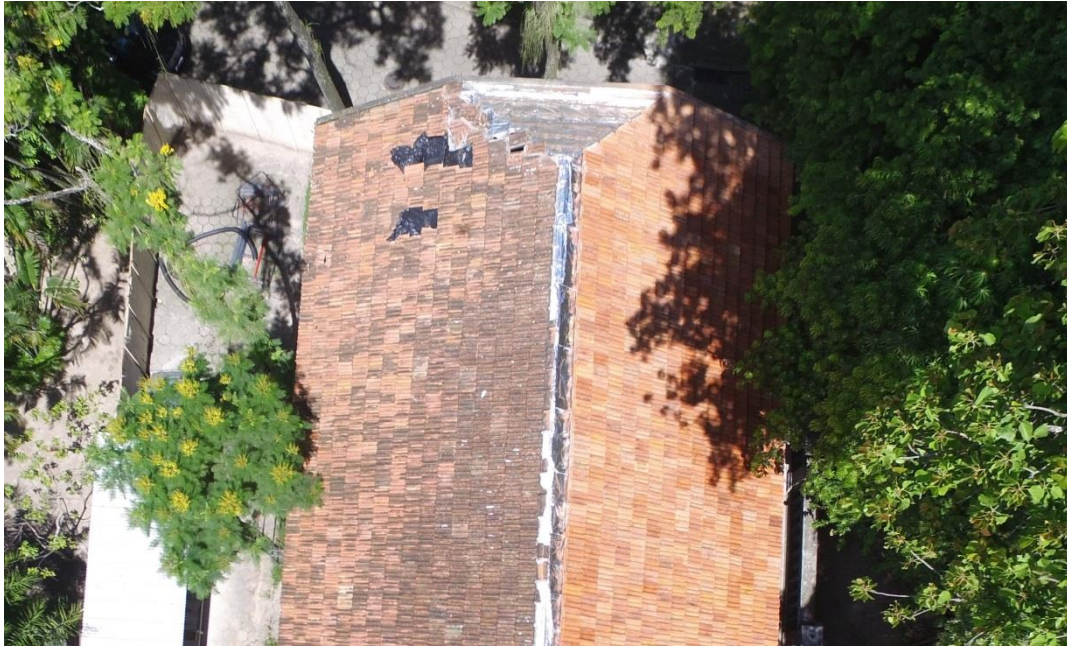
Figura 7 - Telhado do Anexo. Lado esquerdo telhas antes da intervenção, lado direito telhas recolocadas após tratamento. Foto aérea tirada em voo de drone. Fonte: DPH/COC.
