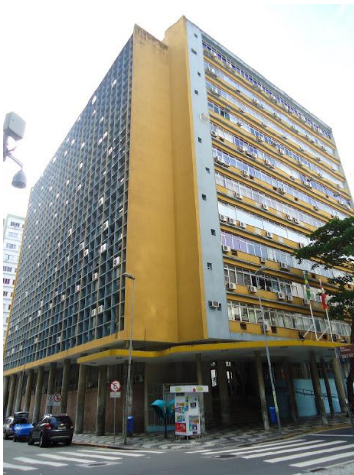
Figura 1 - esquina do Edifício das Diretorias, centro de Florianópolis- SC. Fonte: Disponível em: http://obuscador-sc.blogspot.com/ . Acesso em: 04 de novembro de 2019.
