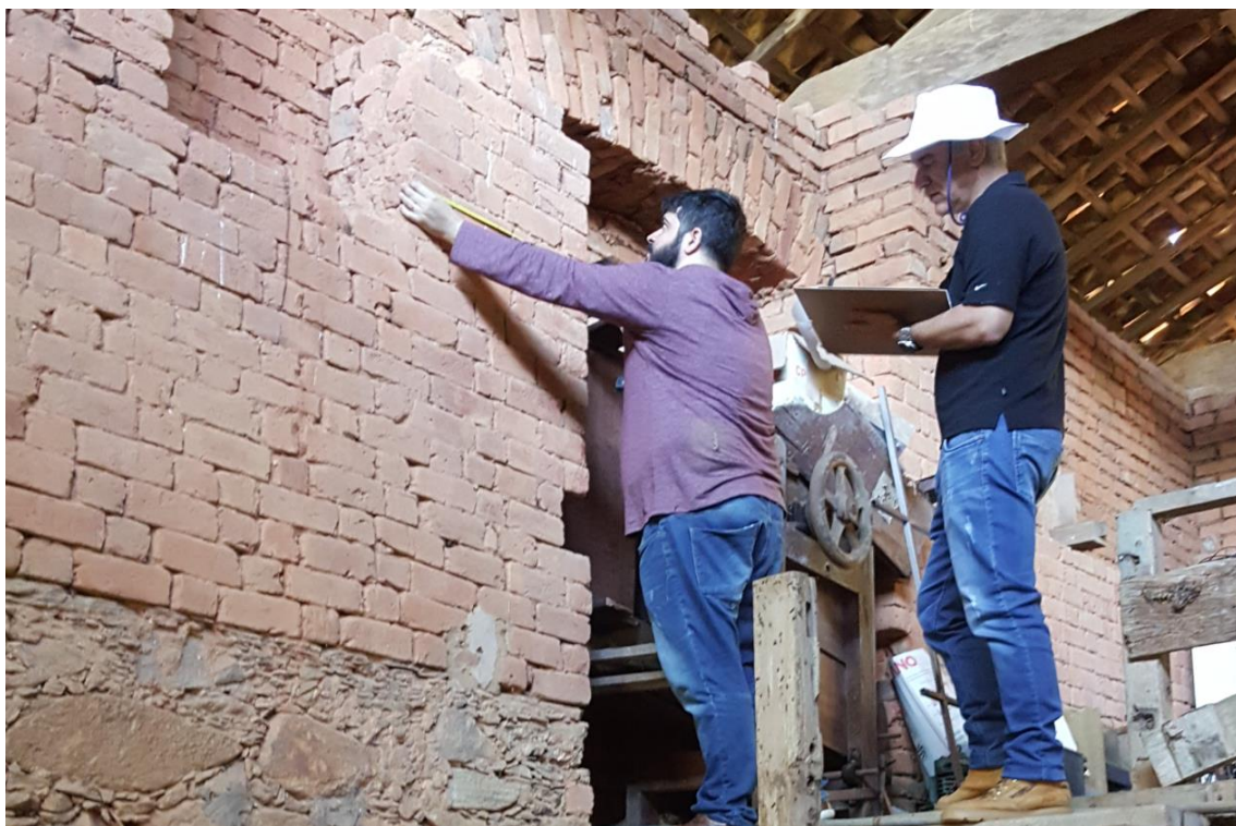
Figura 8 - Fazenda Espírito Santo do Atibaia, Tulha de Pedra, mensuração dos componentes construtivos da alvenaria oeste.
