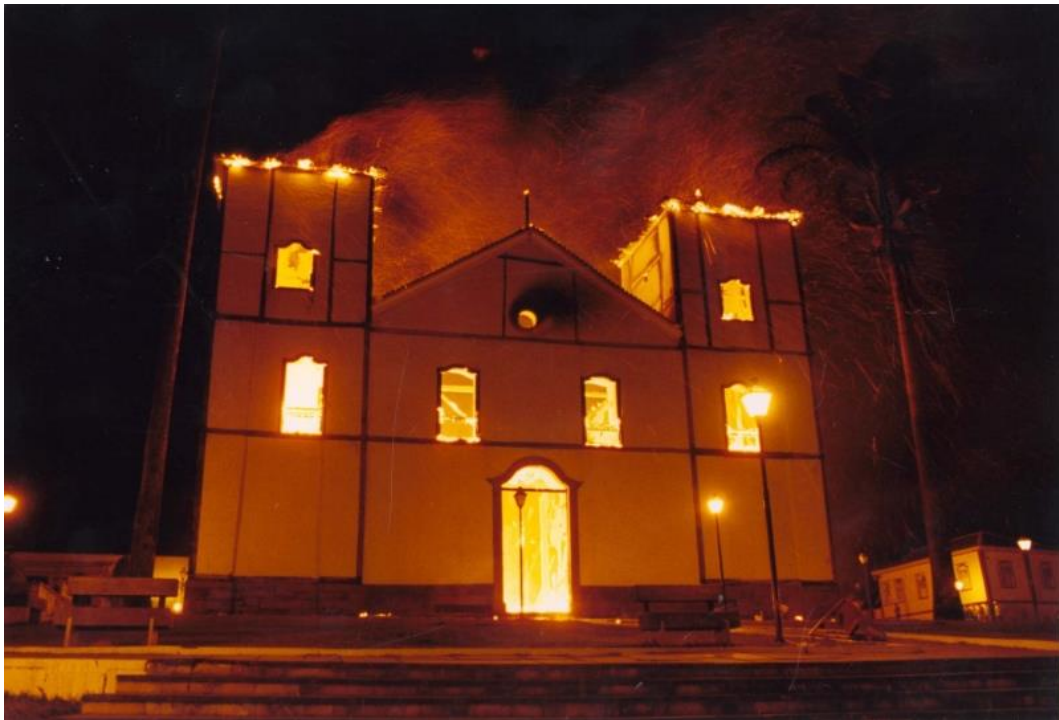
Figura 15 - Incêndio na Igreja Matriz de N. S. do Rosário, Pirenópolis/GO.
