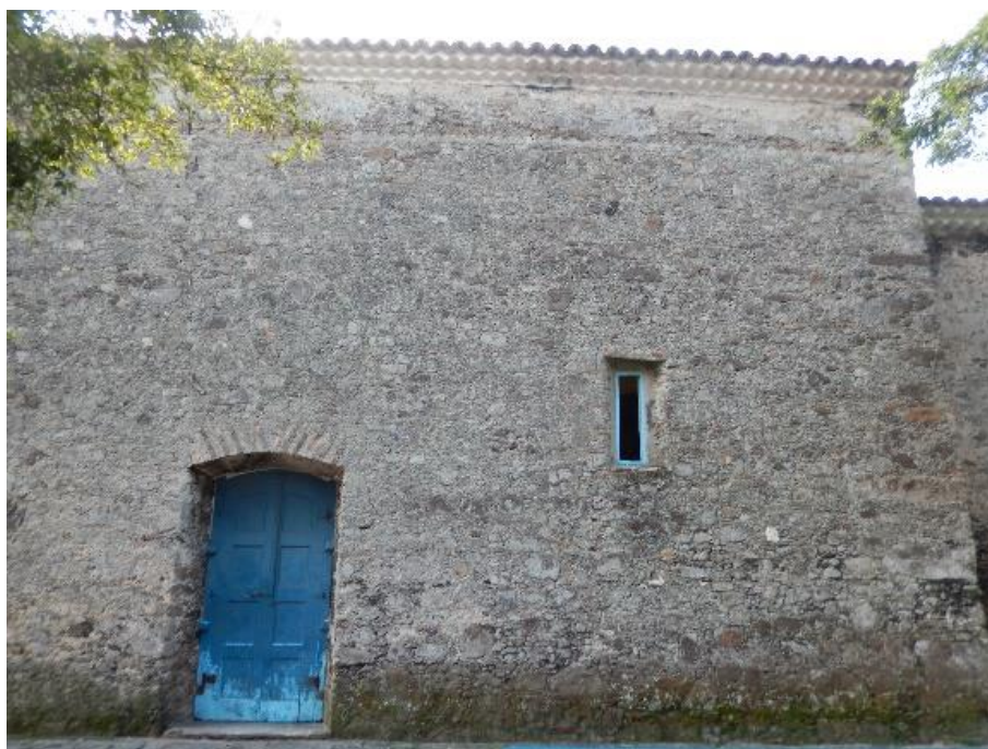
Figura 4 - Fachada lateral, alteamento, técnica construtiva pedra e cal aparente. Foto: Regina Helena Vieira Santos, 2018.
