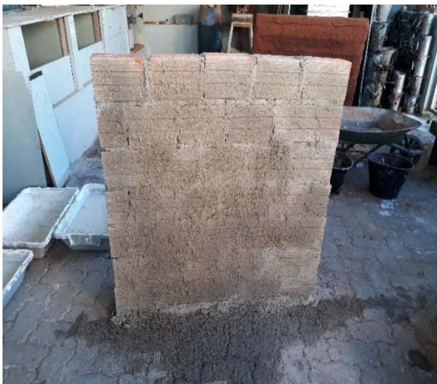
Figura 5 - Parede após a finalização do chapisco, Conjunto II da Universidade Franciscana, Santa Maria – RS. Fonte: Acervo da acadêmica Bruna de Cássia C. Gonçalves.
