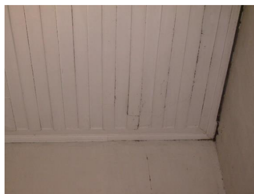
Forro em saia e camisa de cômodo da residência.
