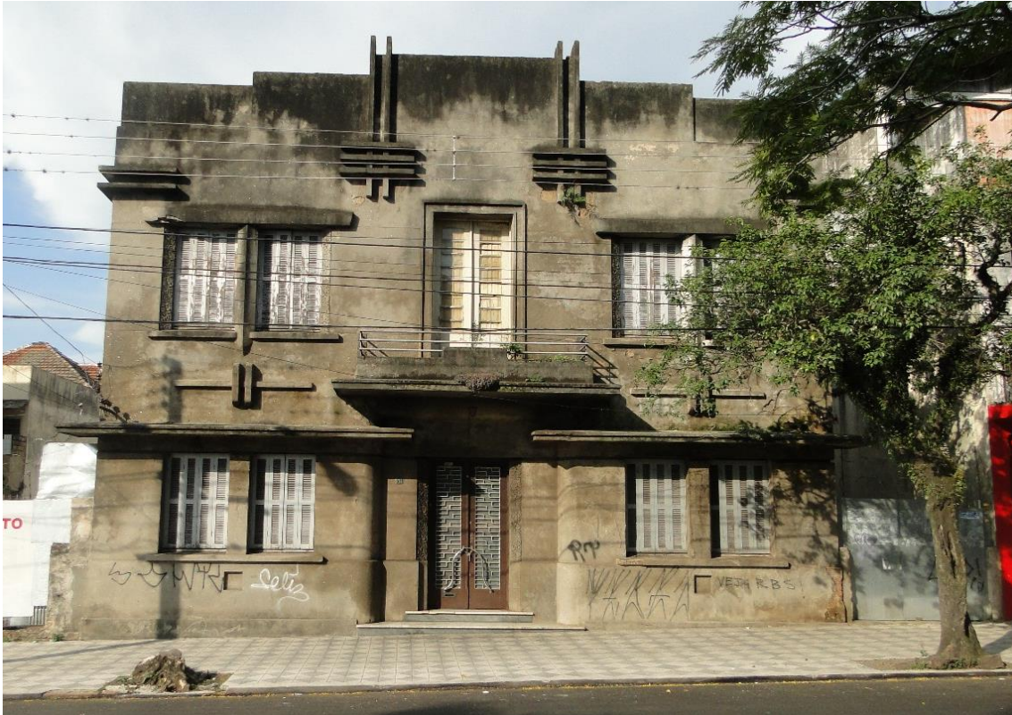
Figura 2 - Fachada principal da Residência. Fonte: Arquivo pessoal da autora, 03 de abril de 2019.
