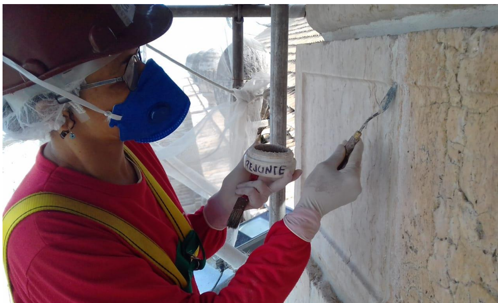
Figura 7 - Colaboradora trabalhando na recomposição do rejuntamento. Fonte: acervo dos autores.
