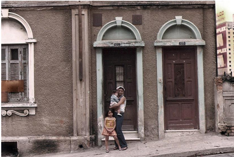
Figura 5 - Rua Jandaia, em 1978. Trecho de edificação construída sobre o muro de arrimo e prováveis moradoras do entorno. Fonte: Fotografia de Paulino Tarraf. NASCIMENTO, 2015.
