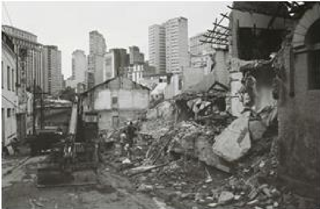
Figura 6 - A demolição das edificações na rua da Jandaia em 1987. Fonte: Fotografia de Israel dos Santos Marques. Disponível em www.acervosdacidade.prefeitura.gov.sp.br . Acesso em 22 jul. 2019.
