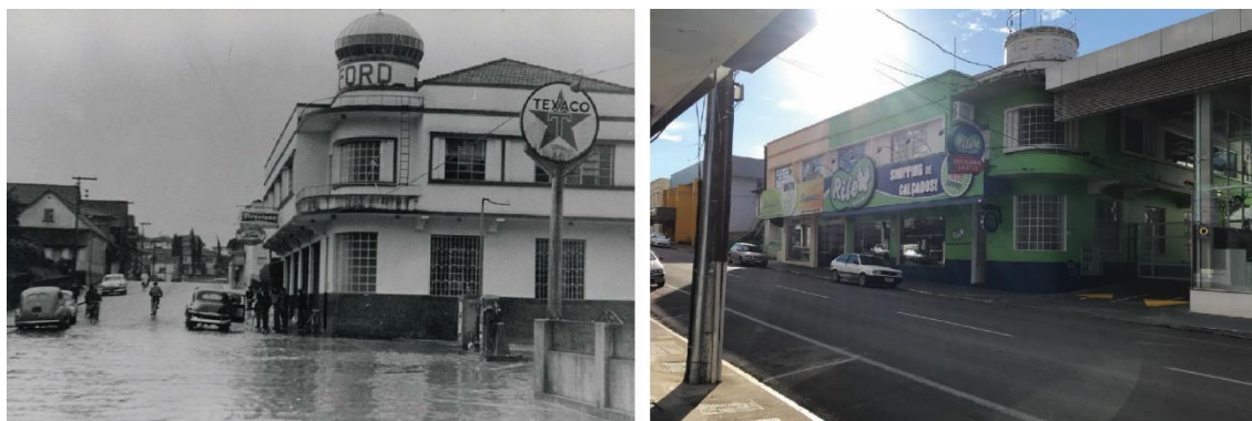
Figura 1 - Comparação entre edificação original e situação atual da edificação código 85, classificada como de interesse histórico e que não é tombada. Nota-se o abuso de publicidade, descaracterização e poluição visual. Rua Felipe Schmidt.
