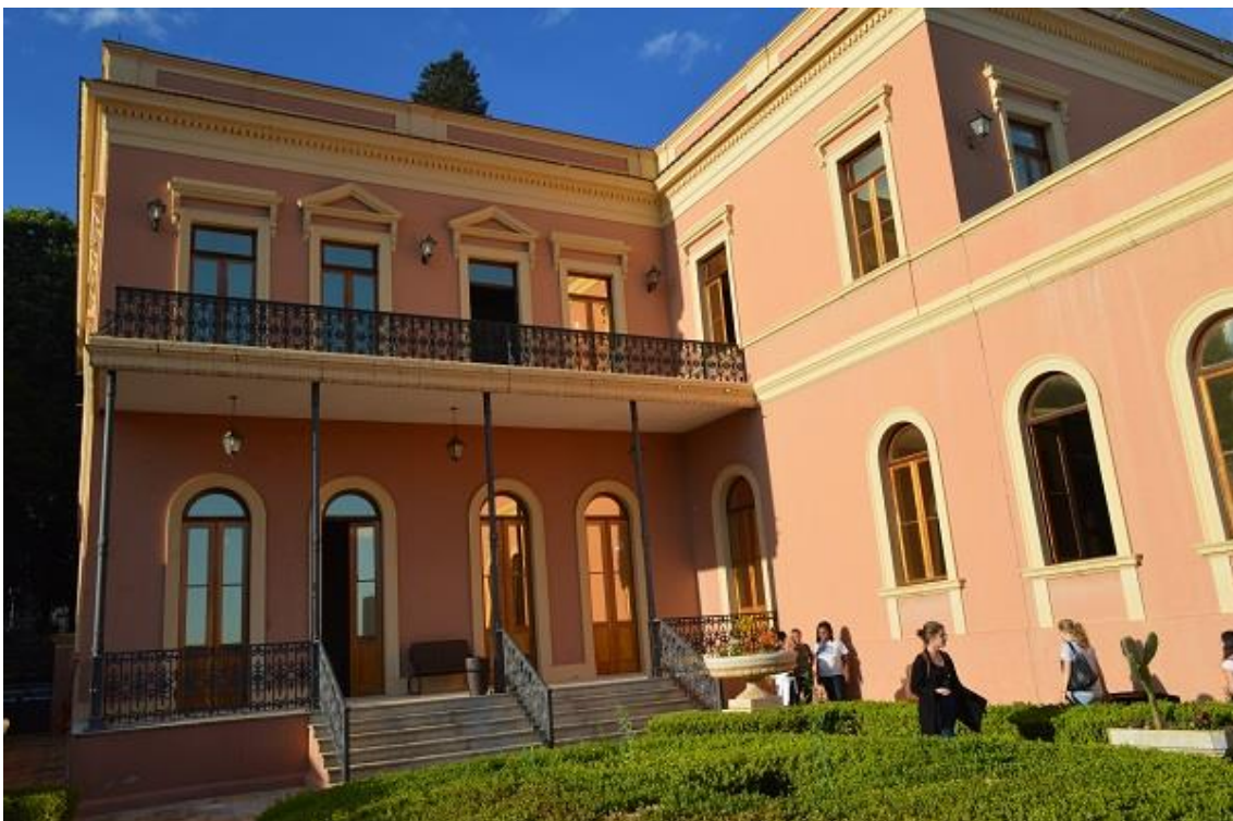
Figura 6 - Palacete Bento Carlos, vista externa (posterior). Fonte: fotografia da autora, 2016.
