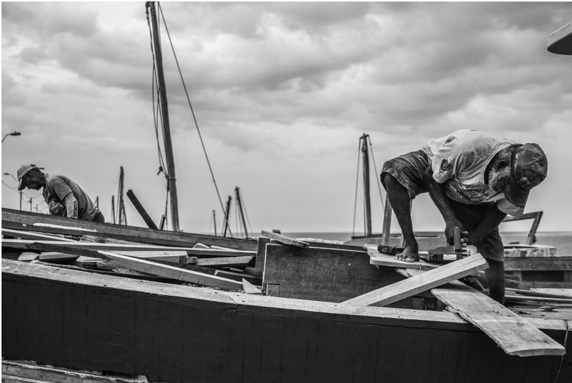
Figura 5 - Mestre carpinteiro Chico Elias trabalhando na construção de um bote bastardo. Fonte: fotografia de Pedro Cela, 12 de maio de 2016.
