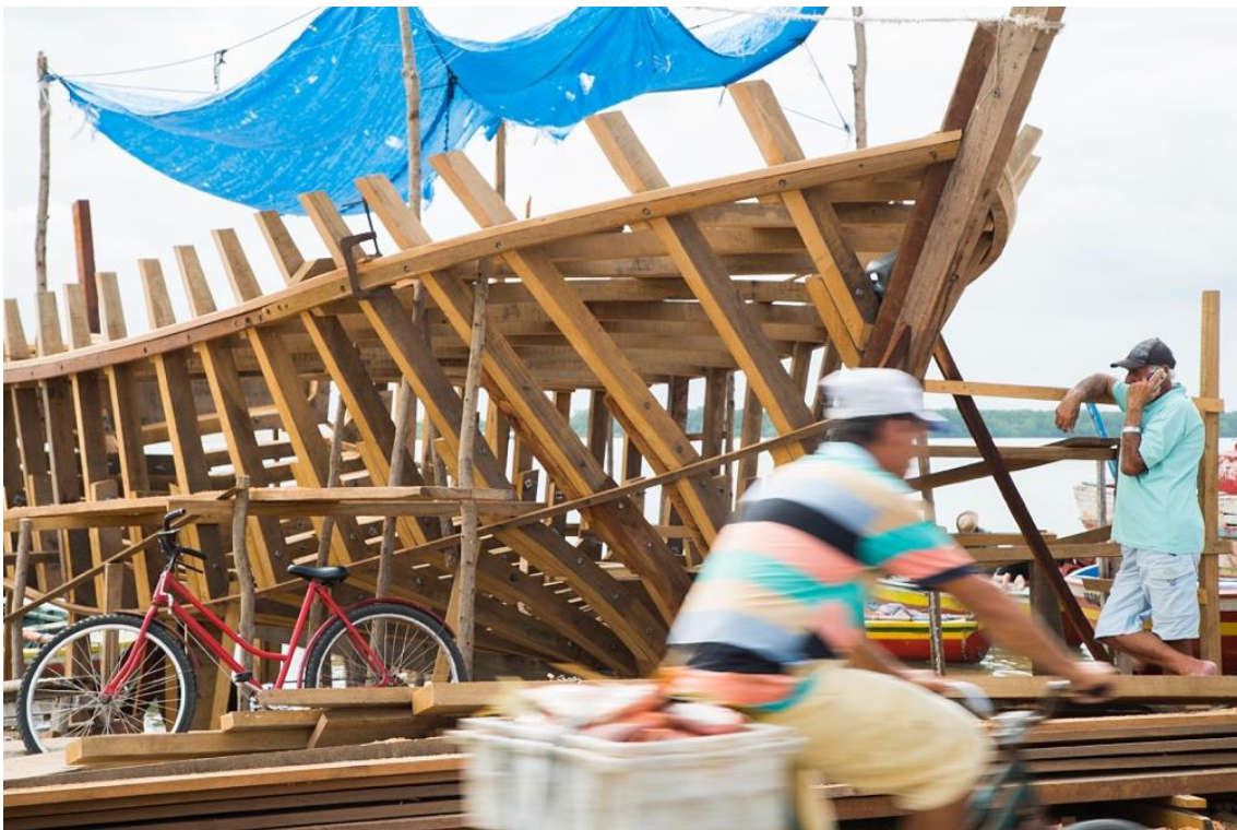
Figura 4 - Bote bastardo em processo de construção. Fonte: fotografia de Pedro Cela, 11 de maio de 2016.
