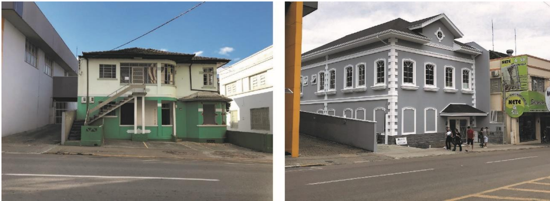
Figura 5 - À esquerda, edificação código 84, demolida durante o processo de estudo. À direita, edificação construída no mesmo lugar, seguindo as regras da Lei da Padronização Arquitetônica. Rua Felipe Schmidt. Fonte: As autoras, 2018.
