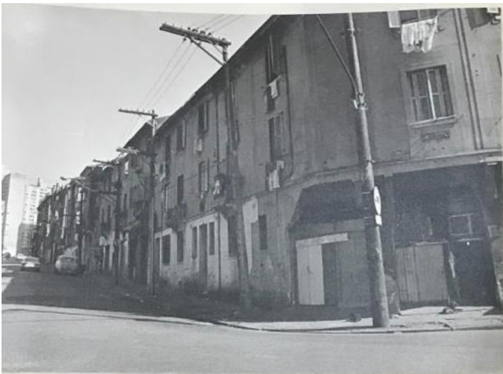
Figura 3 - Vista do conjunto de imóveis da rua da Assembleia, em 1983. Fonte: Fotografia de Teresa Maria Emídio. SÃO PAULO (município), 1983, p. s/n.
