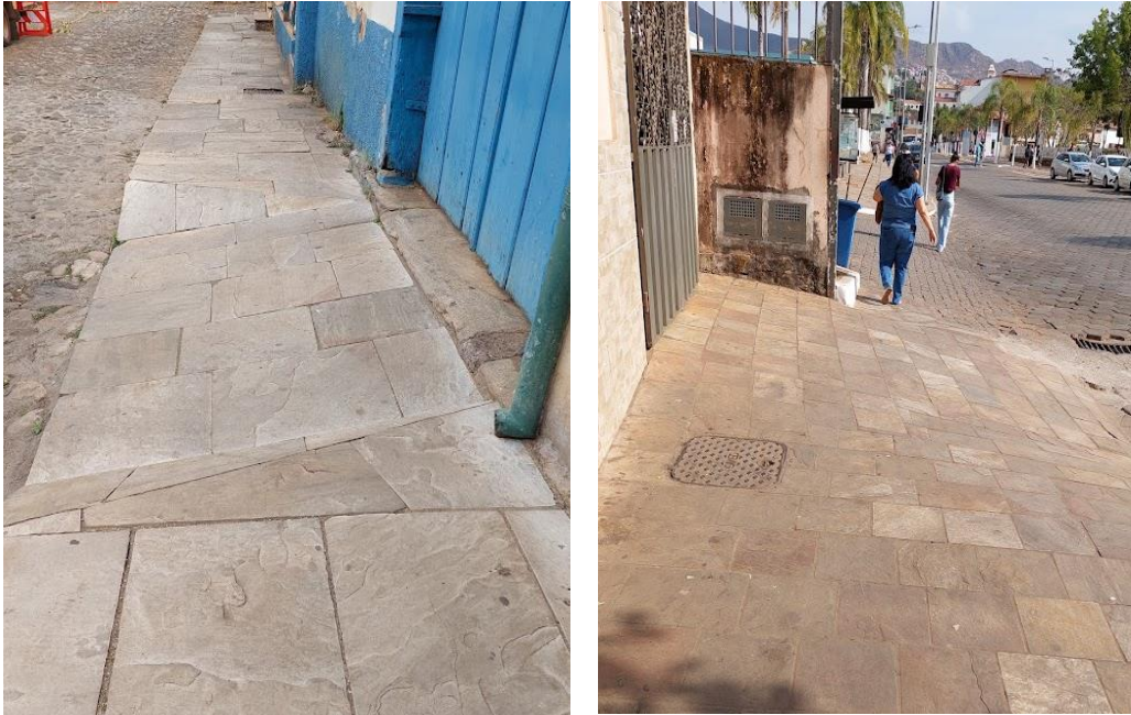
Figura 29- Rampas de acesso na faixa livre de circulação
