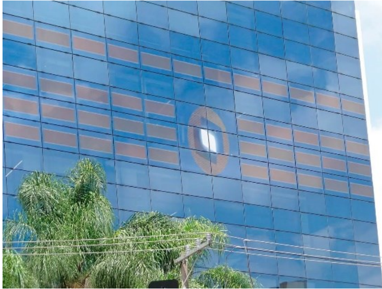
Figura 2.1: Imagens da instalação vertical BIPV da empresa Sunew com painéis OPV integrados ao vidro. Fonte: SUNEW e TOTVS.
