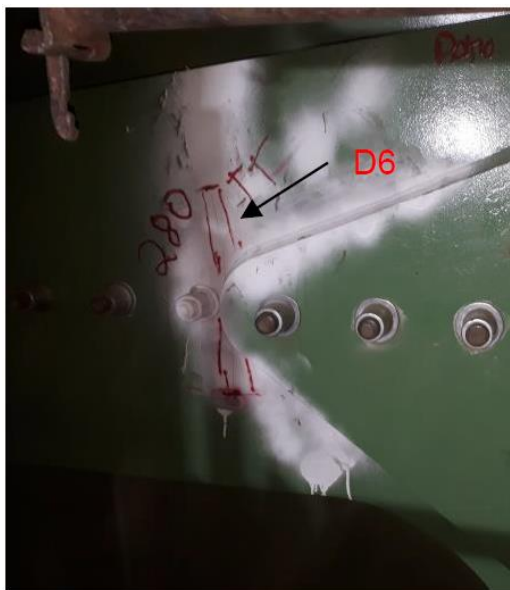
Figura 4.22: Descontinuidade D6 na solda ligando as chapas parafusadas.
