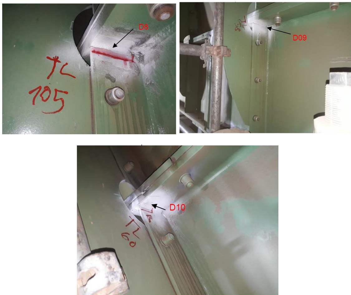
Figura 4.24: Descontinuidade D8, D9 e D10 na solda das mesas com os enrijecedores.
