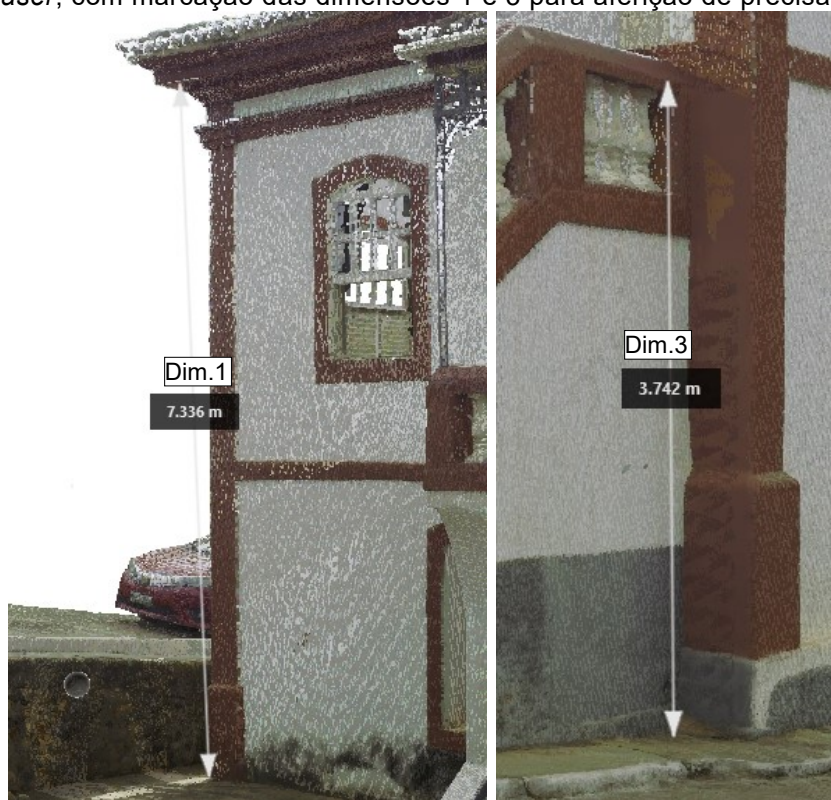
Figura 36 – Perspectivas da nuvem de pontos da Cadeia Velha, oriunda do escaneamento a laser , com marcação das dimensões 1 e 3 para aferição de precisão.
