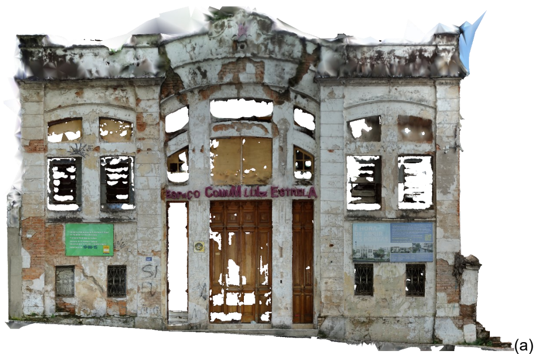
Figura 76 - Ortofotos da fachada frontal do ECLE no modelo de malha triangular irregular texturizada obtidas por (a) restituição fotogramétrica e (b) escaneamento com Lidar portátil.
