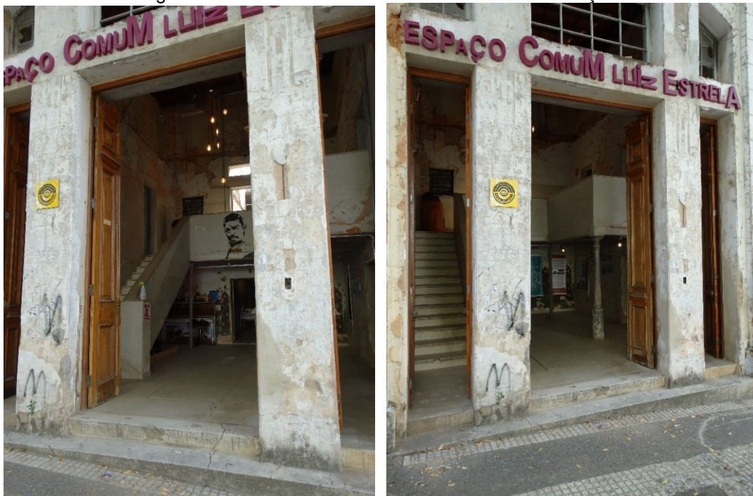
Figura 55 - Fachada frontal e hall central da edificação.
