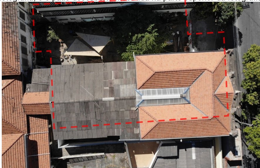
Figura 52 - Aerofotografia do imóvel, que contém a porção coberta pelo telhado cerâmico à direita da fotografia e seu centro, a porção coberta pelo telhado de amianto mais à esquerda da fotografia, e o pátio descoberto mostrada na parte superior da fotografia.
