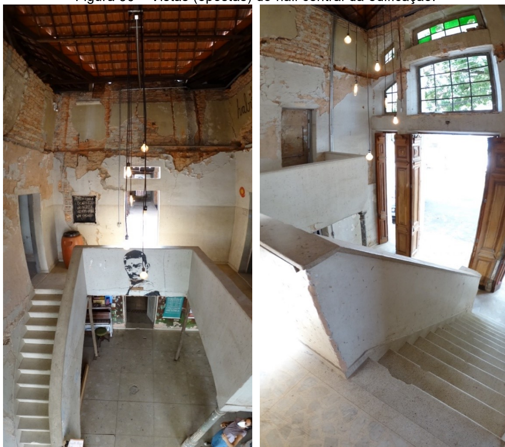
Figura 56 – Vistas (opostas) do hall central da edificação.
