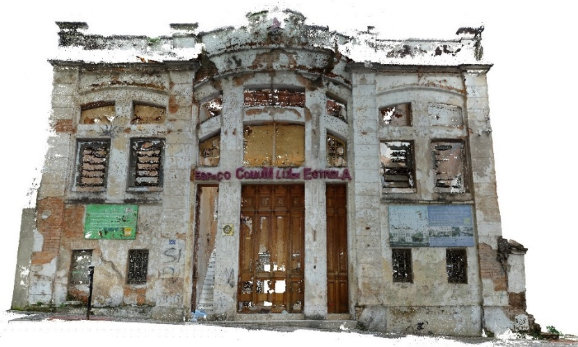
Figura 69 - Perspectiva da nuvem de pontos obtida por restituição fotogramétrica, no software Autodesk Recap.
