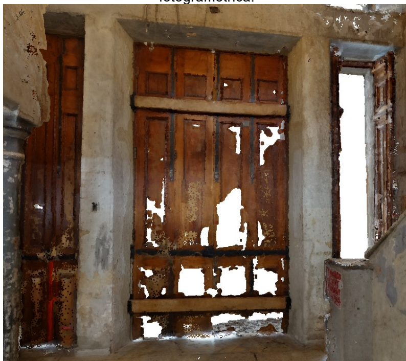
Figura 95 - Perspectiva do hall central do ECLE, na nuvem de pontos obtida por restituição fotogramétrica.
