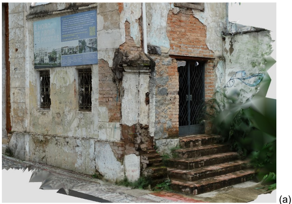
Figura 77 – Perspectivas externas de parte das fachadas frontal e lateral direita do ECLE no modelo de malha triangular irregular texturizada obtidas por (a) restituição fotogramétrica e (b) escaneamento com Lidar portátil.
