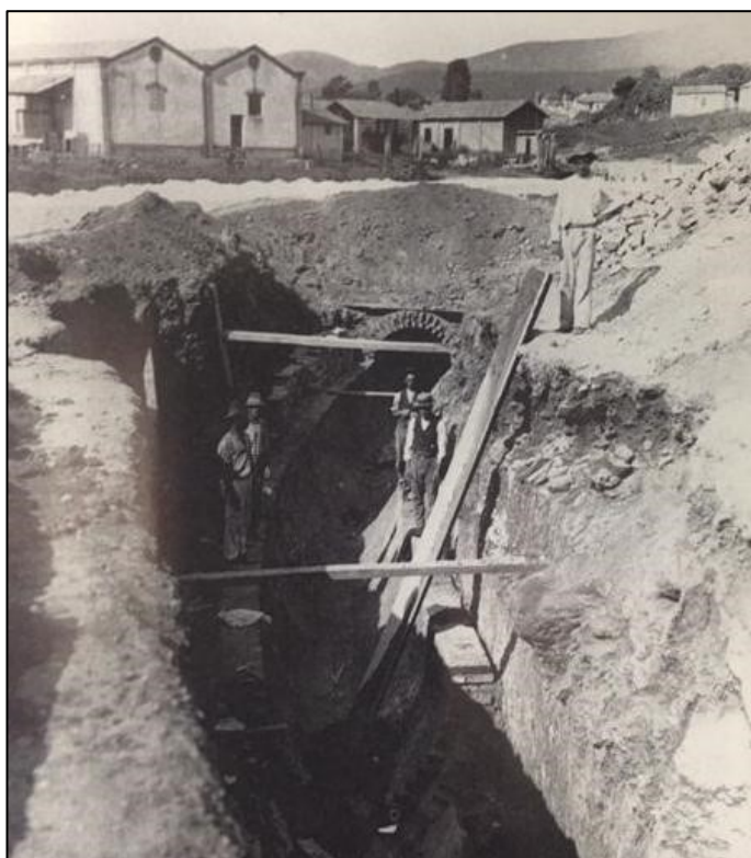
Figura 80 – Construção de um emissário de esgotos no início de Belo Horizonte
