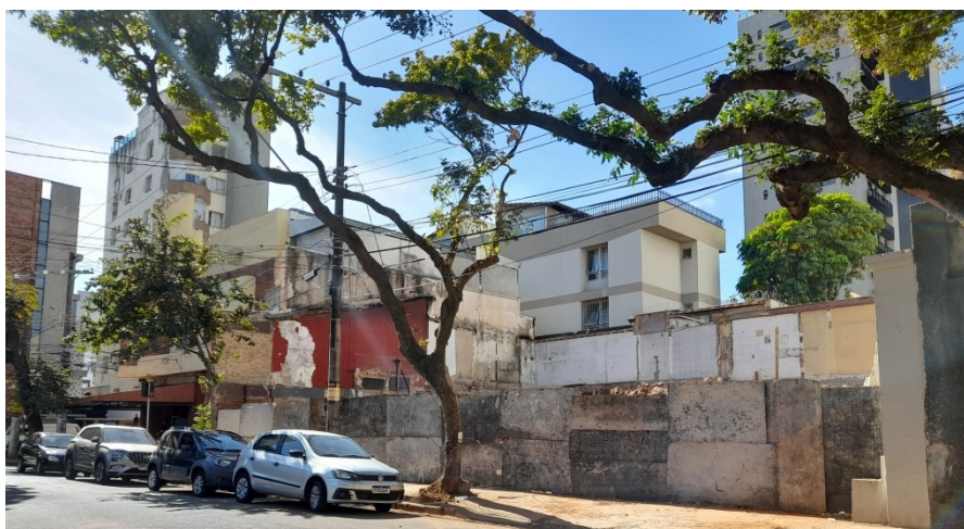
Figura 147: Edificação demolida em frente ao núcleo 12
