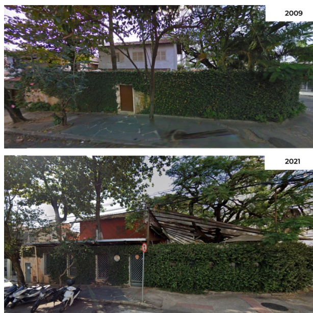
Figura 180: Modificações na edificação na Rua Laranjal 459
