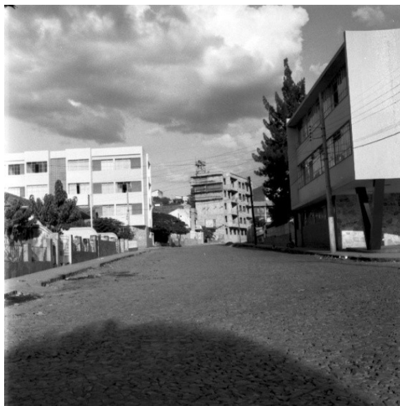
Figura 32: Prédios na Rua Vitório Marçola, sem data
