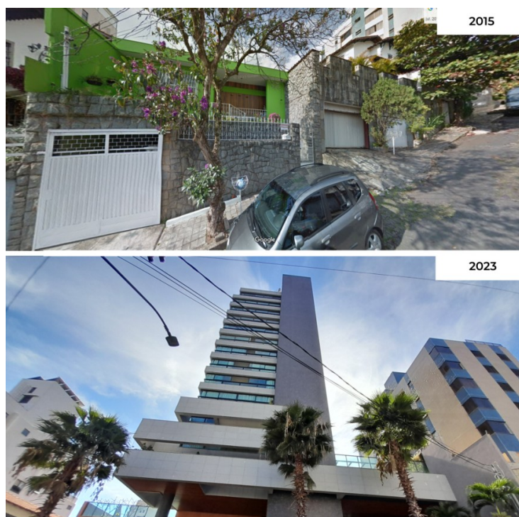
Figura 173: Transformações de lotes na Rua Penafiel 377
