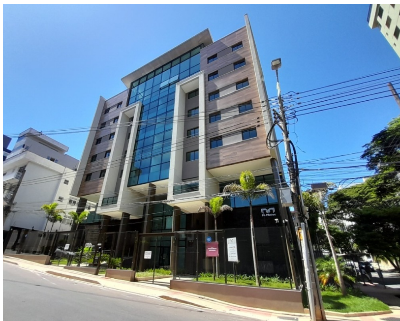
Figura 68: Prédio residencial na Rua Bambuí 893
