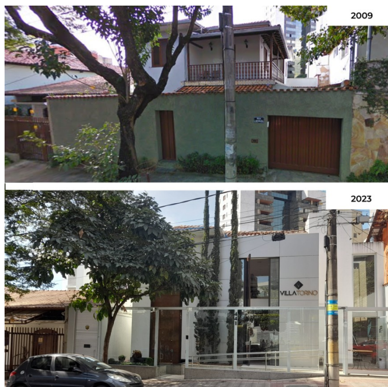
Figura 181: Modificações na edificação a Rua Laranjal 441
