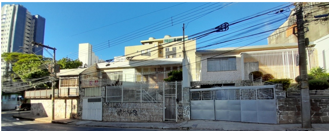
Figura 120: Conjunto de casas na Rua Montes Claros
