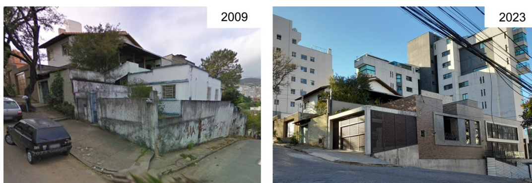
Figura 83: Transformações em edificação na Rua Minas Novas 192
