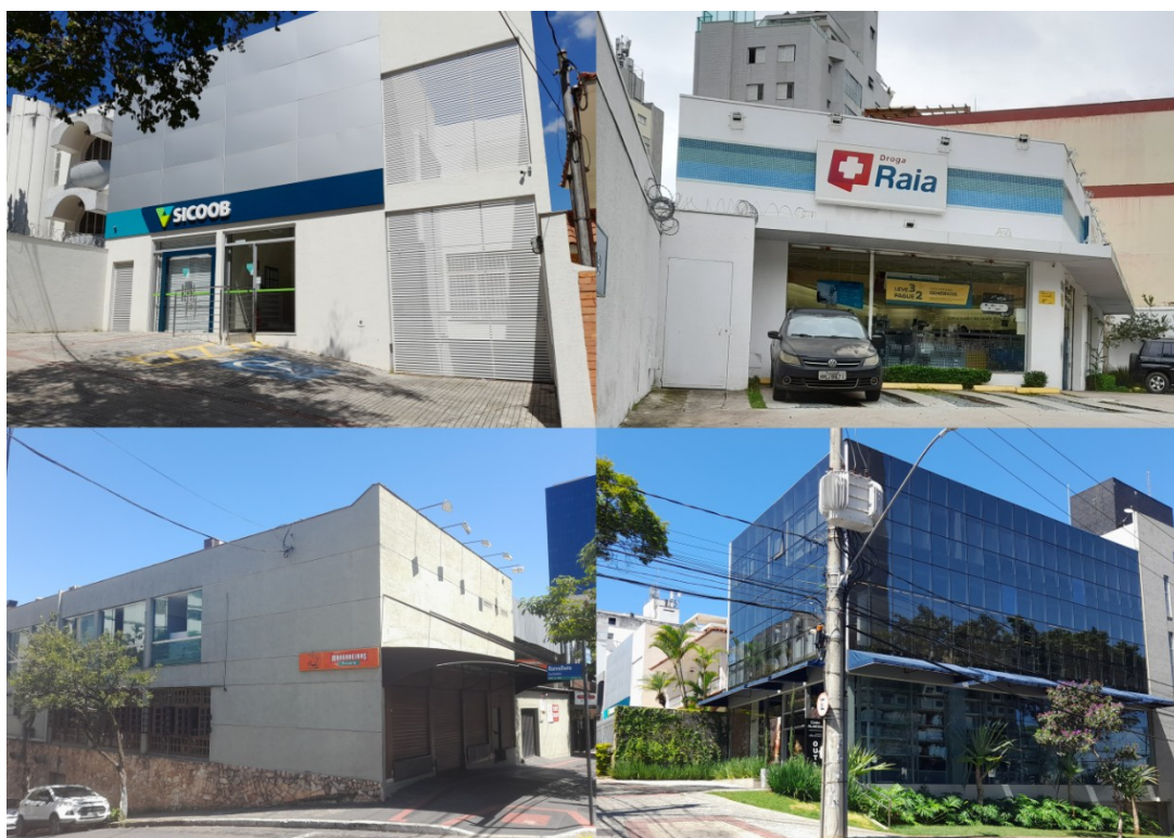
Figura 70: Exemplos de edificações da tipologia genérica
