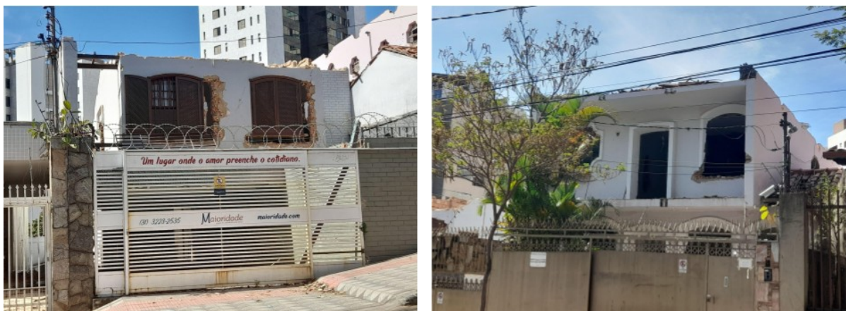
Figura 182: Casas em processo de demolição na Rua Laranjal
