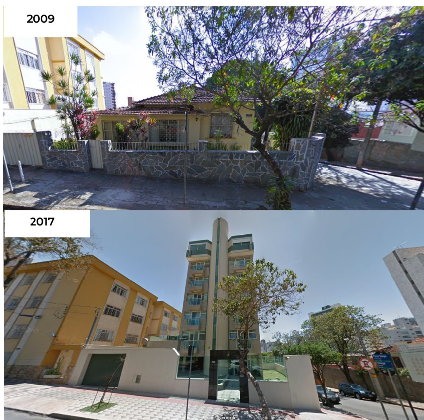
Figura 57: Transformações do lote na Rua Passatempo 210
