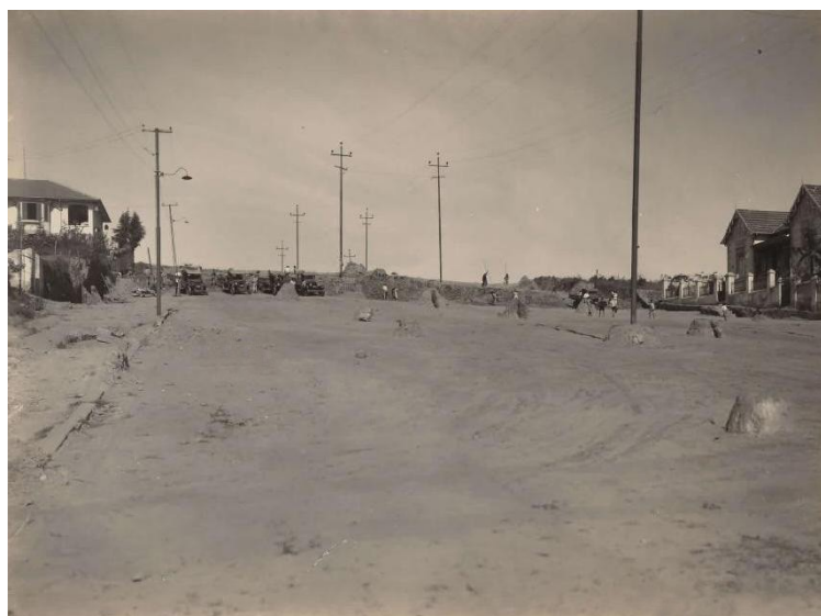
Figura 23: Terraplanagem da Avenida Afonso Pena e Praça do Cruzeiro, 1928
