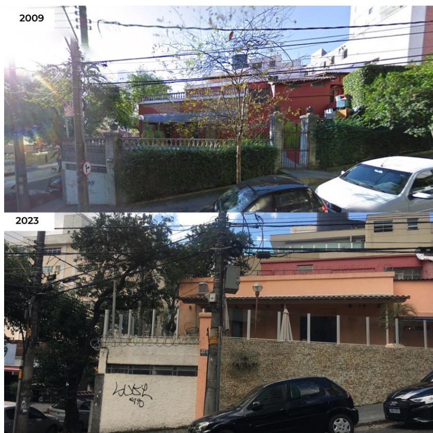
Figura 60: Transformação da fachada na edificação na Rua Minas Novas 14
