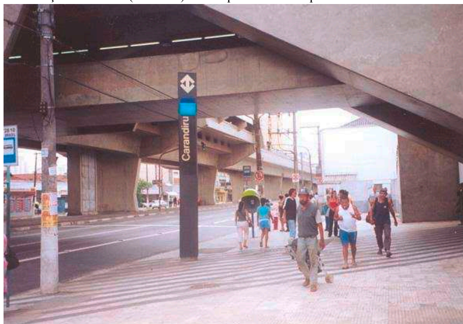
Figura 49 — Estação Carandiru (sem data) onde é possível ver as pilastras ao fundo ainda sem os murais
