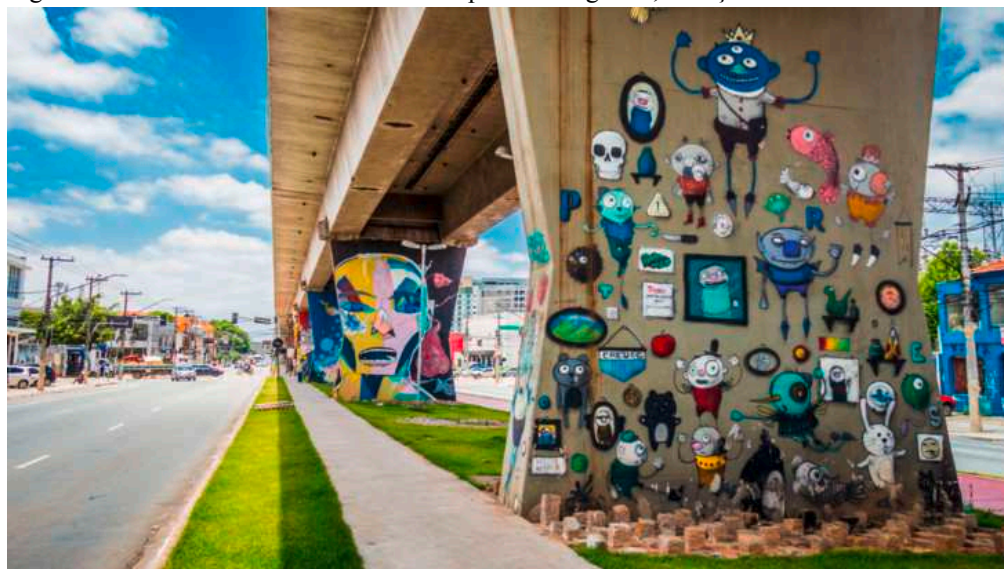
Figura 51 — Obras do MAAU-SP onde se pode ver a grama, a calçada e a ciclofaixa ao fundo
