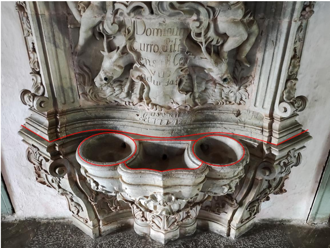
Figura 62 - Vista superior do tanque do lavatório de São Francisco.
