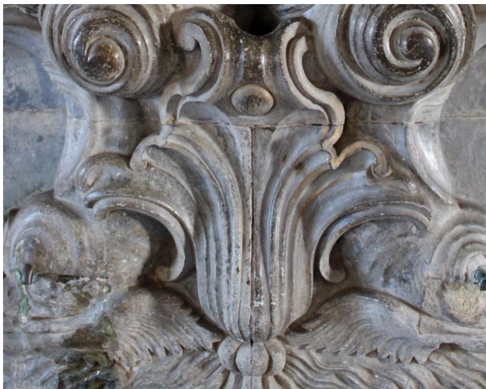
Figura 34 - Palmeta no quadro principal do lavatório do Carmo.
