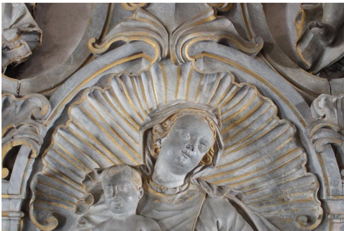
Figura 41 - Concha no quadro principal do lavatório do Carmo.
