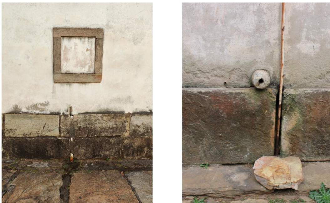
Figura 13 - Vestígios de encanamento dos lavatórios do Carmo (à esquerda) e de São Francisco (à direita).
