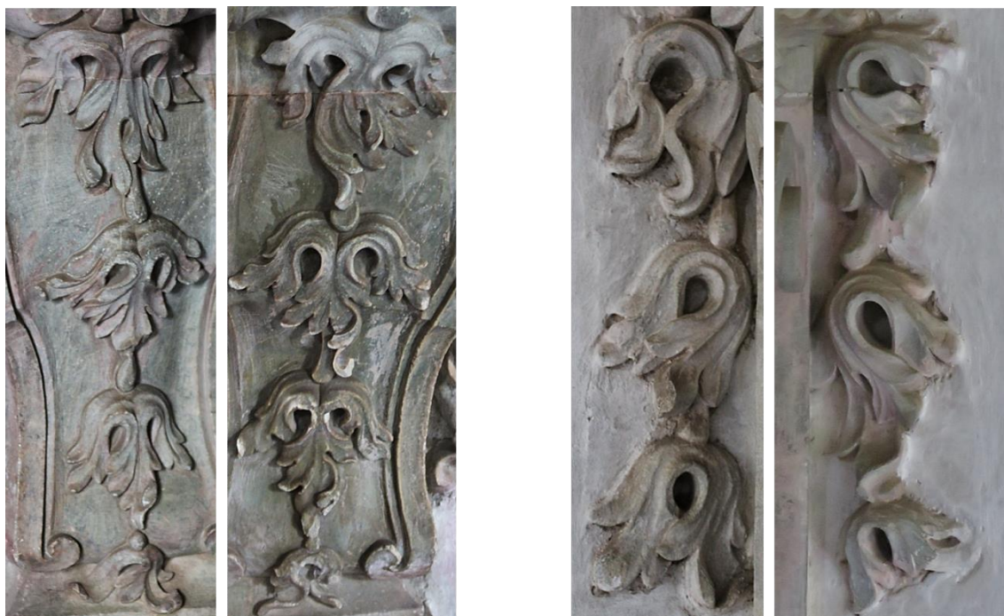
Figura 76 - Arranjos fitomorfos nos pedestais e laterais dos quartelões do lavatório de São Francisco.
