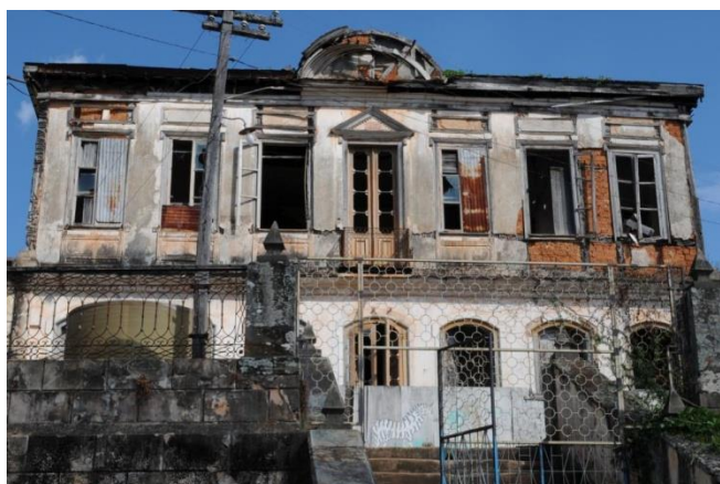
FIGURA 12 – Foto do edifício (Hospício da Diamantina) antes da reforma Fonte: ACERVO DA SANTA CASA DE CARIDADE DE DIAMANTINA, Ano 2010.
