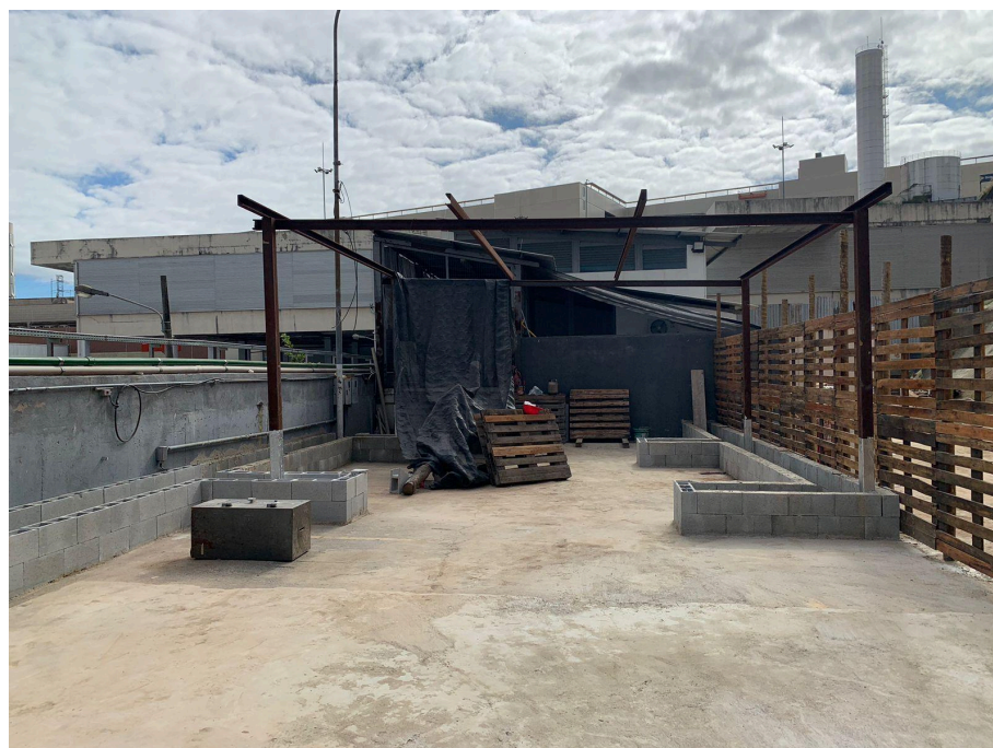
Figura 47 - Foto do local com as floreiras sendo construídas e reutilização da estrutura metálica existente para construção de um pergolado. Fonte: Própria
