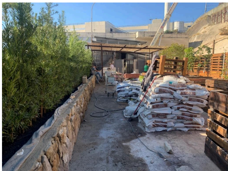
Figura 49 – Processo de plantio do paisagismo e acabamento das floreiras. Fonte: Própria
