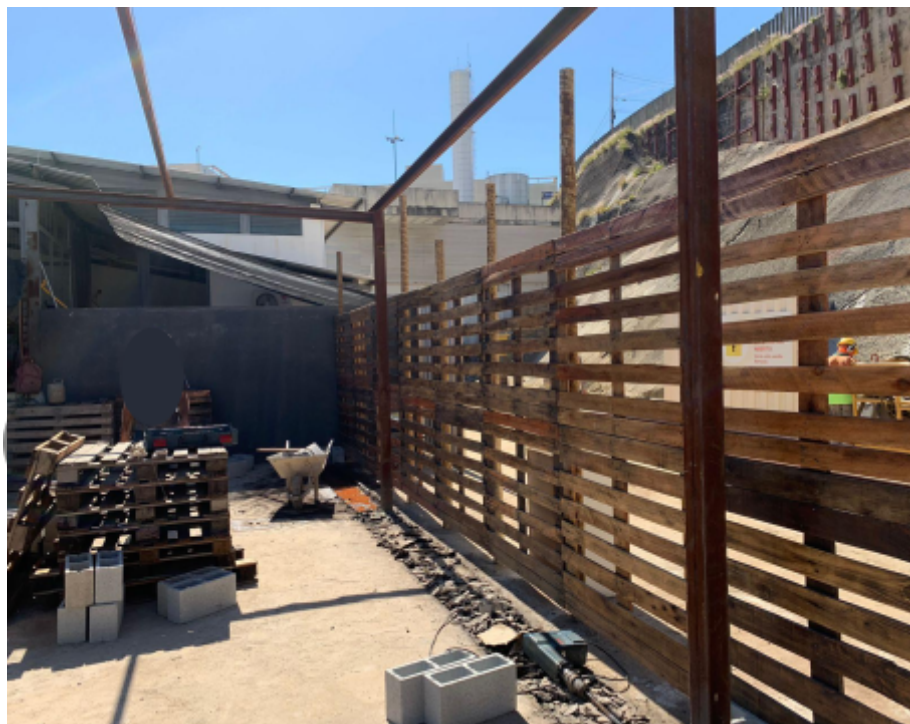
Figura 46 – Iniciando a delimitação do espaço utilizando paletes existentes no Minas Shopping. Fonte: Própria
