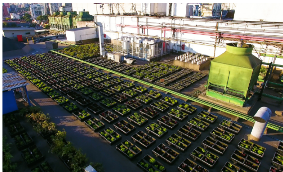
Figura 15 - Foto de parte da área onde foi implantada a horta no telhado do shopping Eldorado Fonte: Própria
