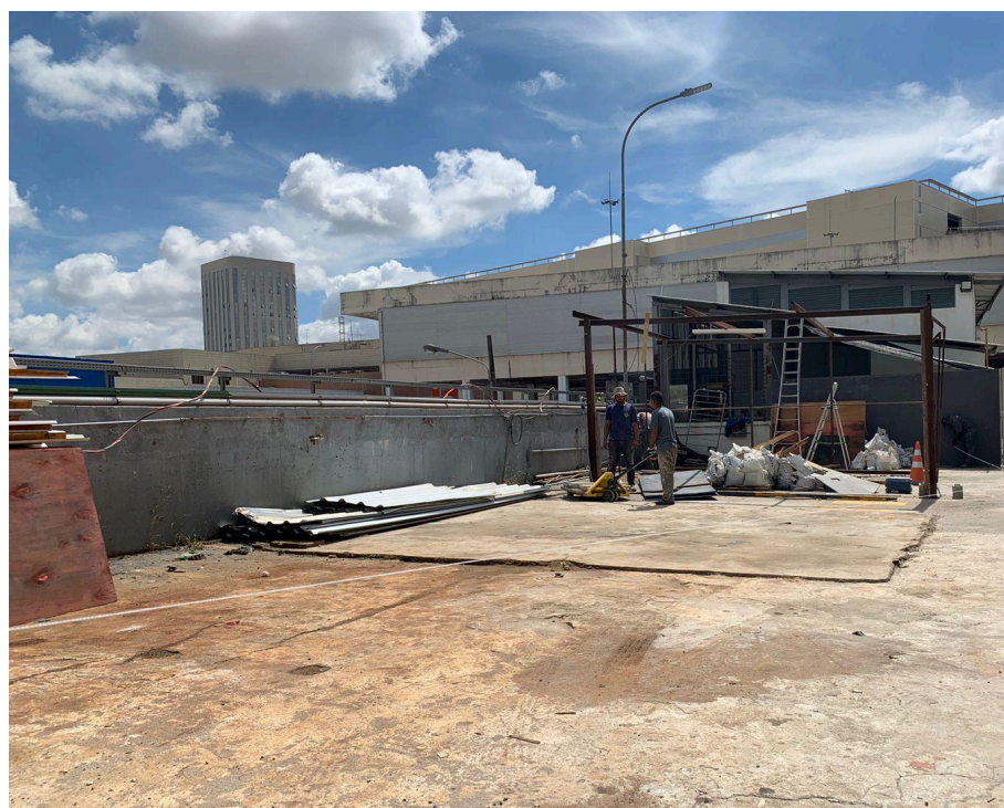
Figura 45 – Processo de desmobilização do local e limpeza da área. Fonte: Própria
