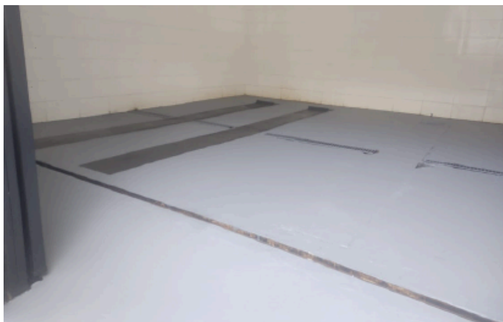
Figura 30 – Foto do local sendo reformado. Fonte: Própria
