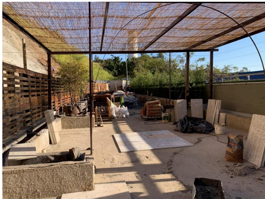
Figura 48 - Fechamento da cobertura do pergolado instalado e preparação do acabamento das floreiras em andamento. Fonte: Própria
