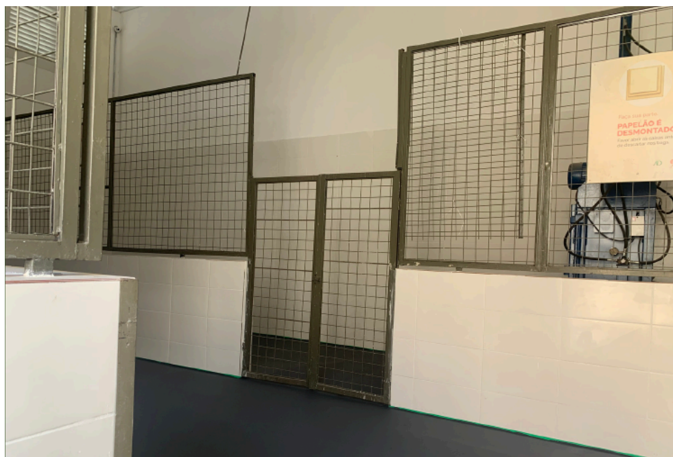
Figura 33 – Foto depois da reforma da área de armazenamento dos resíduos recicláveis. Fonte: Própria
