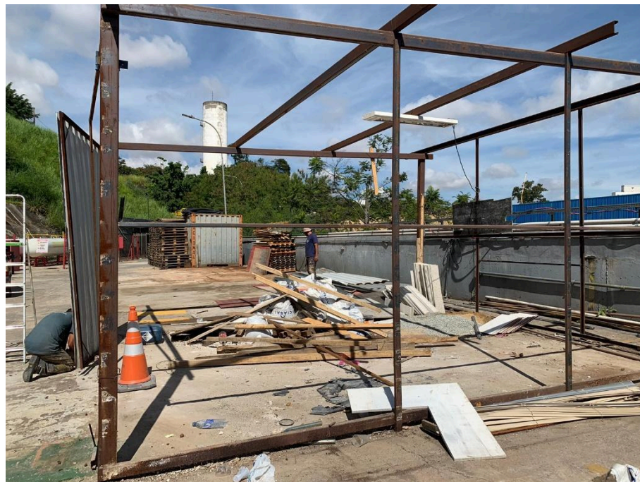
Figura 44 – Processo de liberação do local, desocupação e desmontagem dos itens que não seriam utilizados no projeto. Fonte: Própria
