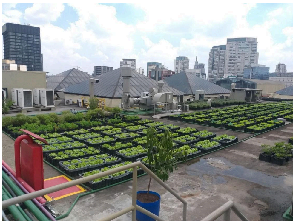
Figura 14 - Foto do telhado do Shopping Eldorado, SP. Área onde foi implantada a horta do empreendimento. Fonte: Própria
