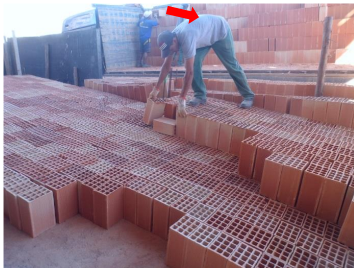
Figura 3 - Trabalhador Posicionando os Tijolos na Pilha FONTE: Autora
