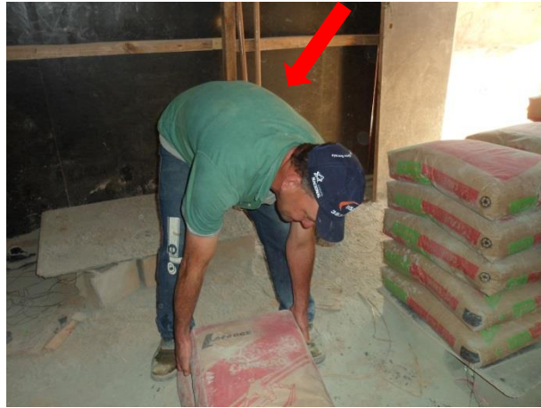
Figura 2- Trabalhador Posicionando o Saco de Cimento no Chão FONTE: Autora
