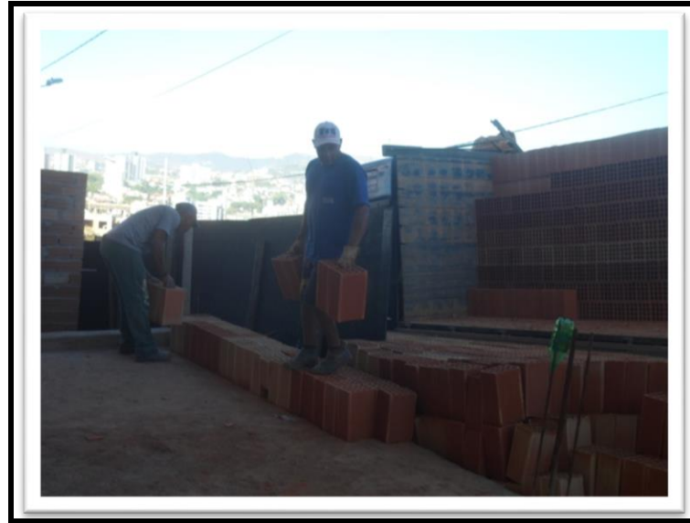
FIGURA 4 – Carregamento de Tijolos.
