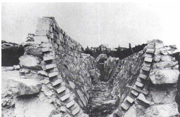
**Figura 45 – Construção de tubulação emissária de esgotos em formato ovoide do sistema unitário (*tout-a-l'égout*) em Belo Horizonte-MG, no início do século XX.**
