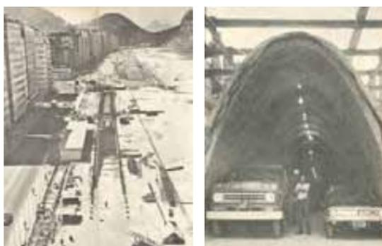
**Figura 31 – Construção do IOZS no Rio de Janeiro. (a) Alargamento da praia de Copacabana. (b) Seção transversal em arco no trecho de Copacabana.**
