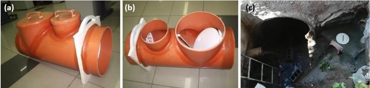
Figura 51 – (a) VTS com tampas; (b): VTS sem tampas; (c): VTS implantadas em PV.
