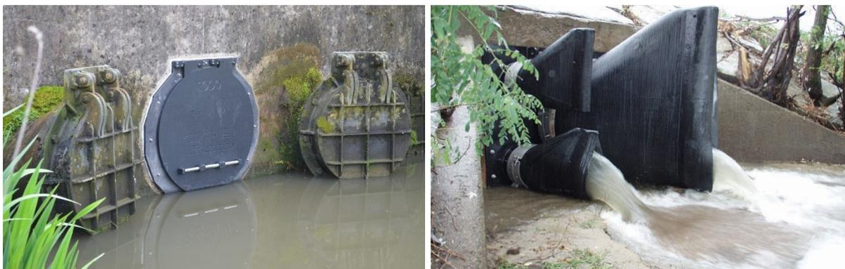
**Figura 65 – Válvulas de retenção para controle de fluxo (*backflow control*). (a) válvulas metálicas do tipo *flap*. (b) válvulas de elastômero flexíveis (*Tideflex*).**
