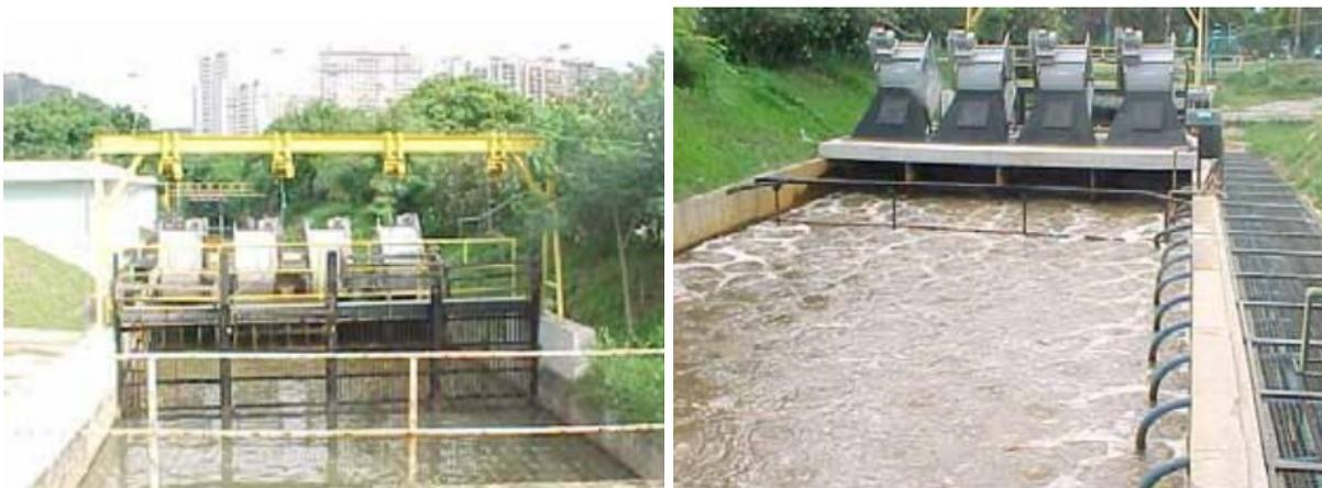
**Figura 41 – Estação de tratamento do rio Carioca. Estrutura de gradeamento (esquerda) e Microaeração da massa líquida (direita).**
