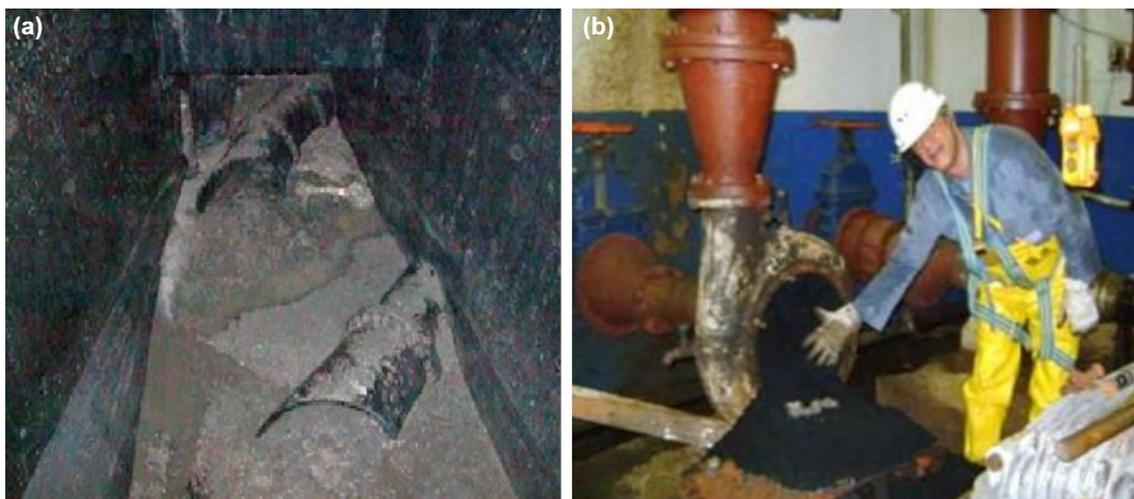
**Figura 66 – Acúmulo de areia (a) poço de sucção (b) voluta de equipamento de bombeamento**
