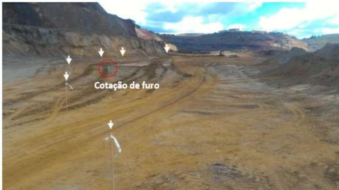
Figura 8: Estaca utilizada para marcação de campo (contribuição do autor, 2019).
