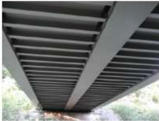
Figura 3.3: Vista inferior do tabuleiro (Rali, 2017 apud Martins, 2020)
