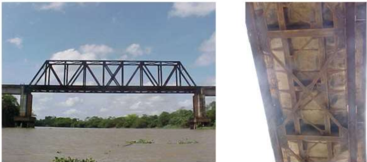
Figura 2.18: Vistas da ponte.
