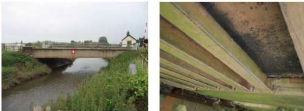
Figura 3.7: Ponte Ferroviária do rio Tone
