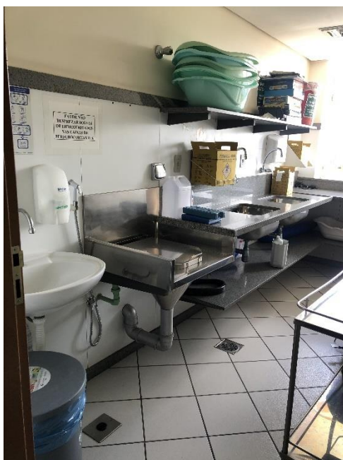
Figura 24: Imagem do levantamento fotográfico do expurgo
