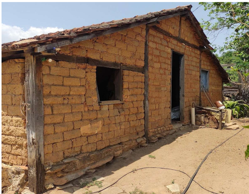
Figura 21 - Casa de adobe à vista, construída no início do século XX, no Vale do Fogaça
