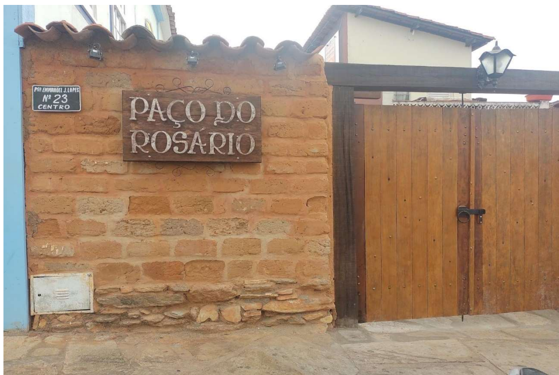
Figura 25 - Muro de entrada em galeria comercial
