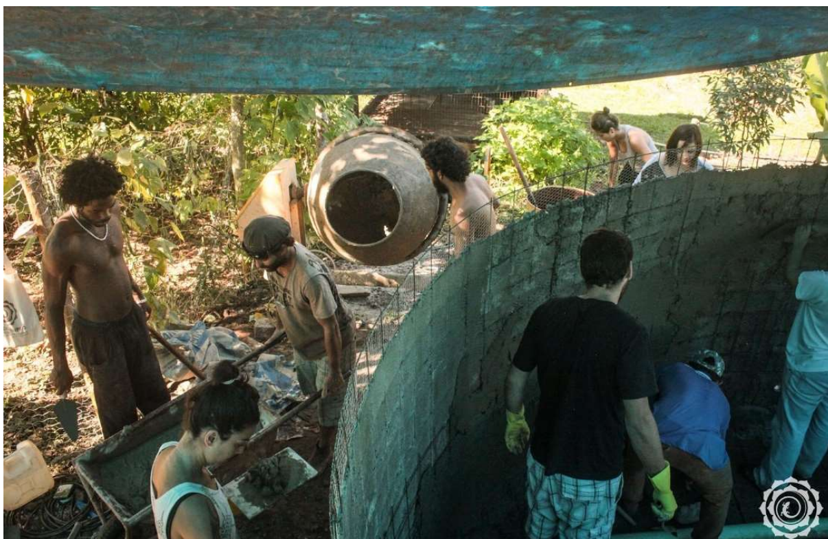
Figura 36 - Execução de uma cisterna de ferrocimento no Ecocentro IPEC
