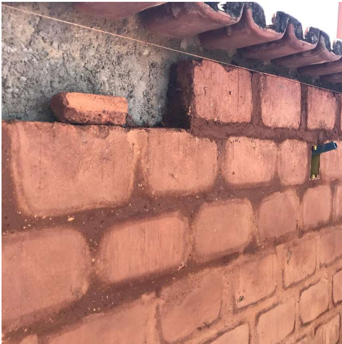
Figura 31 - Muro construído em alvenaria de tijolos cerâmicos revestido com plaquetas de adobe
