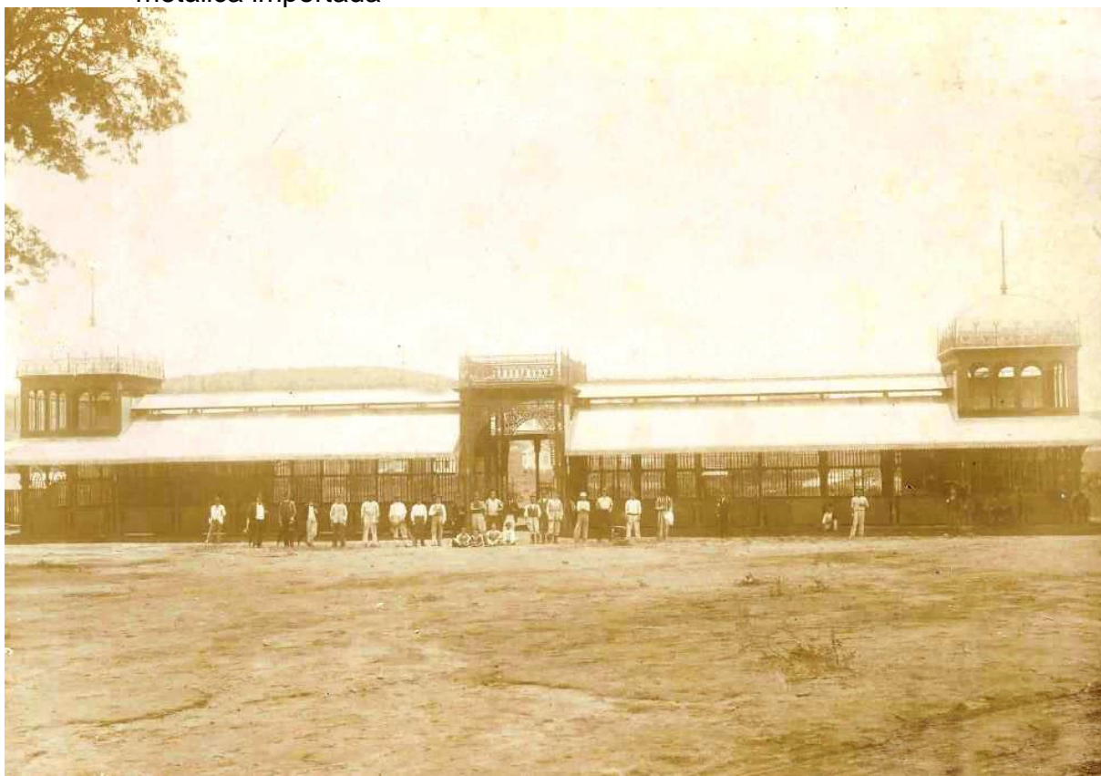
Figura 3 - Mercado Municipal de Belo Horizonte até 1929 – edificação em estrutura metálica importada
