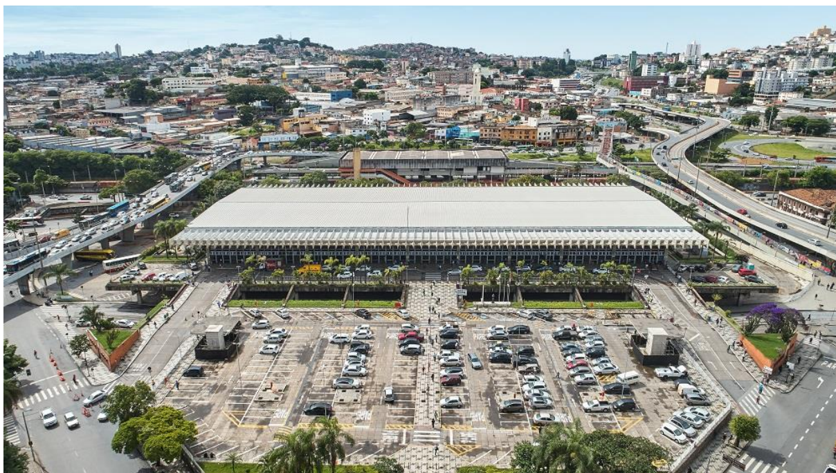
Figura 5 – Atual estação rodoviária de Belo Horizonte
