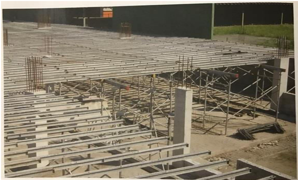
Imagem 1 - Execução de laje com escoramento LTT SH e perfis metálicos
