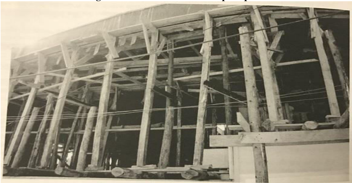
Figura 25 – Fôrma em madeira para pilar
