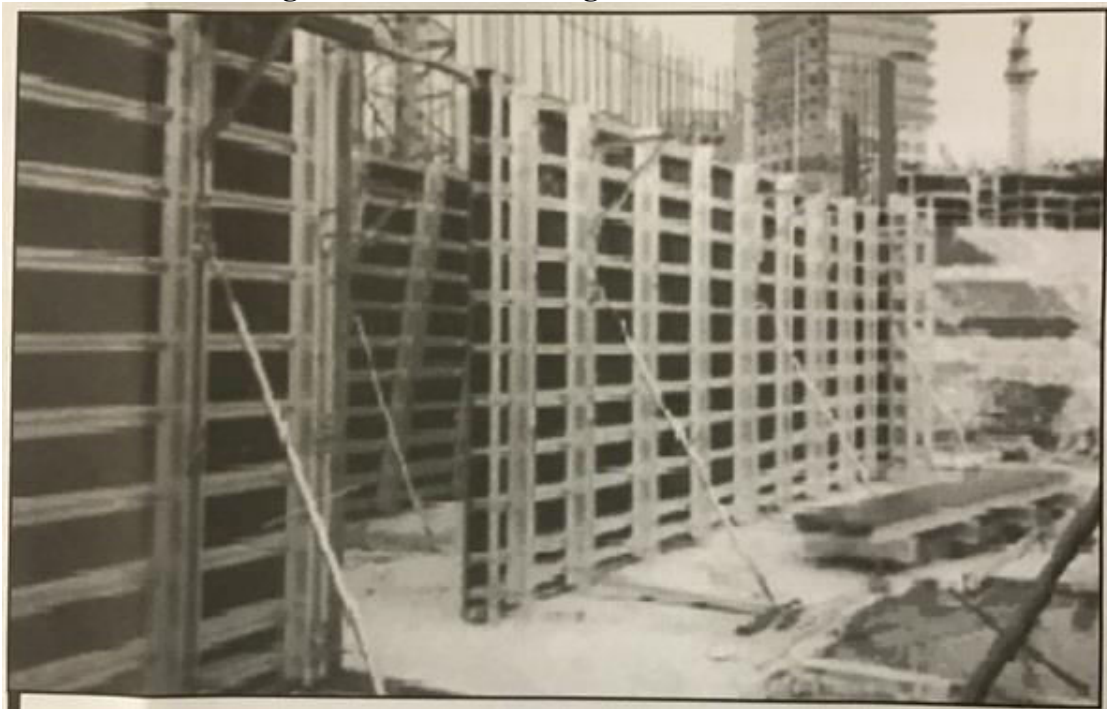
Figura 16 – Fôrmas integralmente metálicas
