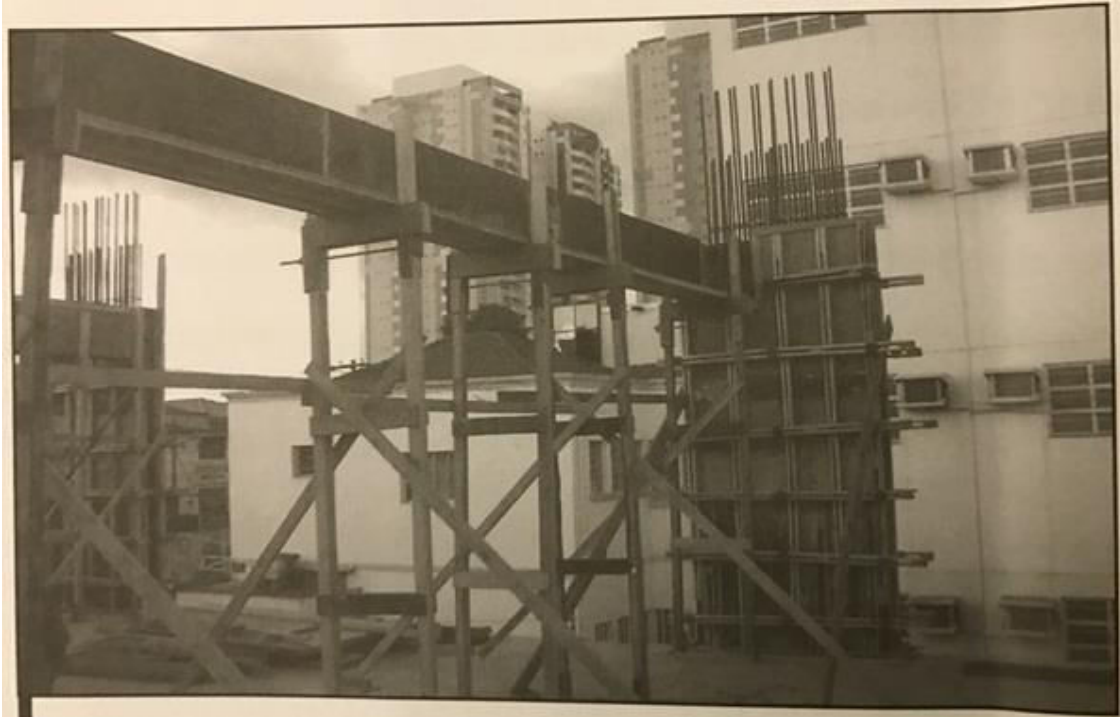
Figura 15 – Sistema de fôrmas integralmente em madeira
