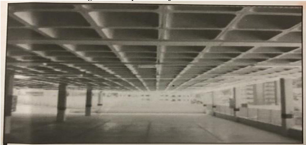
Figura 19 – Aspecto da laje desenformada
