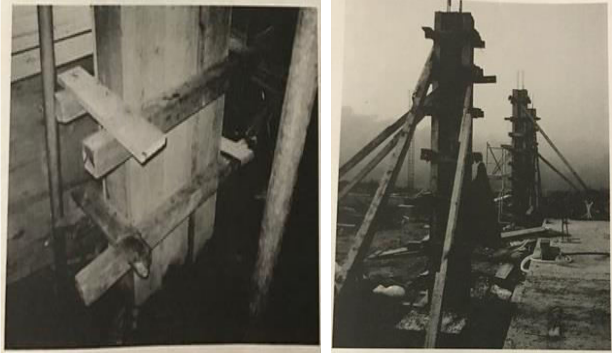
Figura 24 – Fôrma e escoramento de madeira
