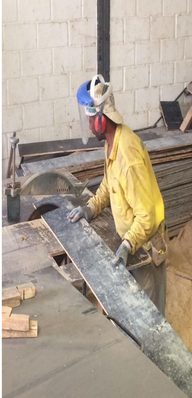
Imagem 6 - Operação na Central de Fôrmas Max Fôrma Técnicas em Construções
