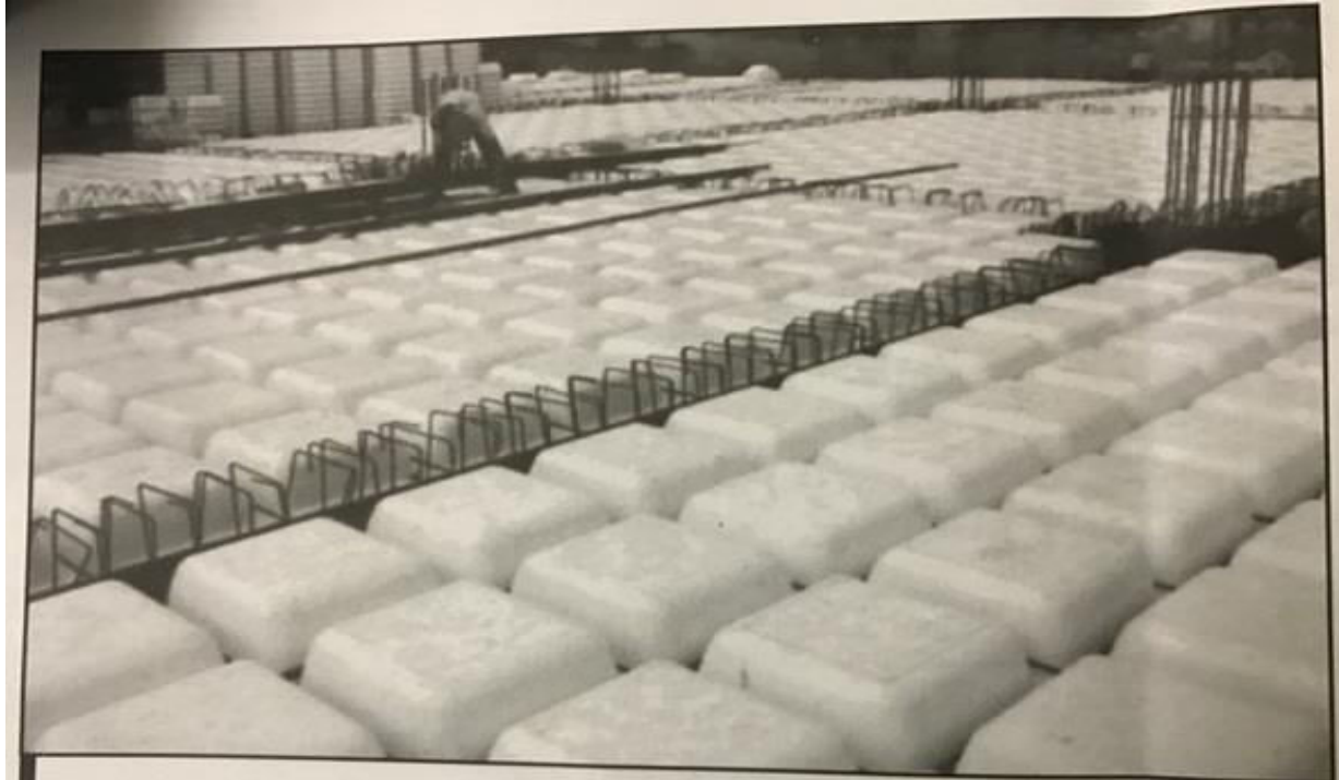
Figura 18 – Fôrma de polipropileno
