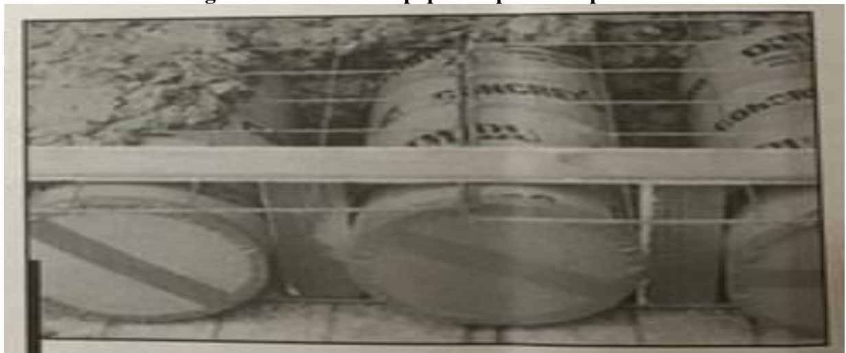
Figura 22 – Fôrmas de papelão tipo caixão perdido
