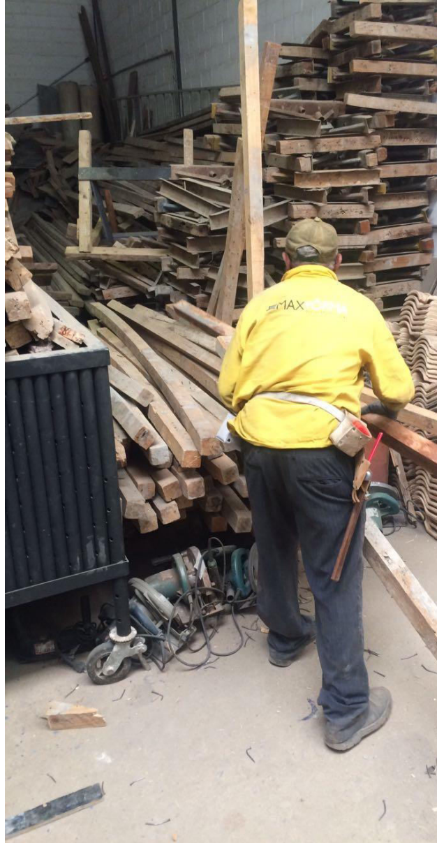
Imagem 5 - Operação na Central de Fôrmas Max Fôrma Técnicas em Construções
