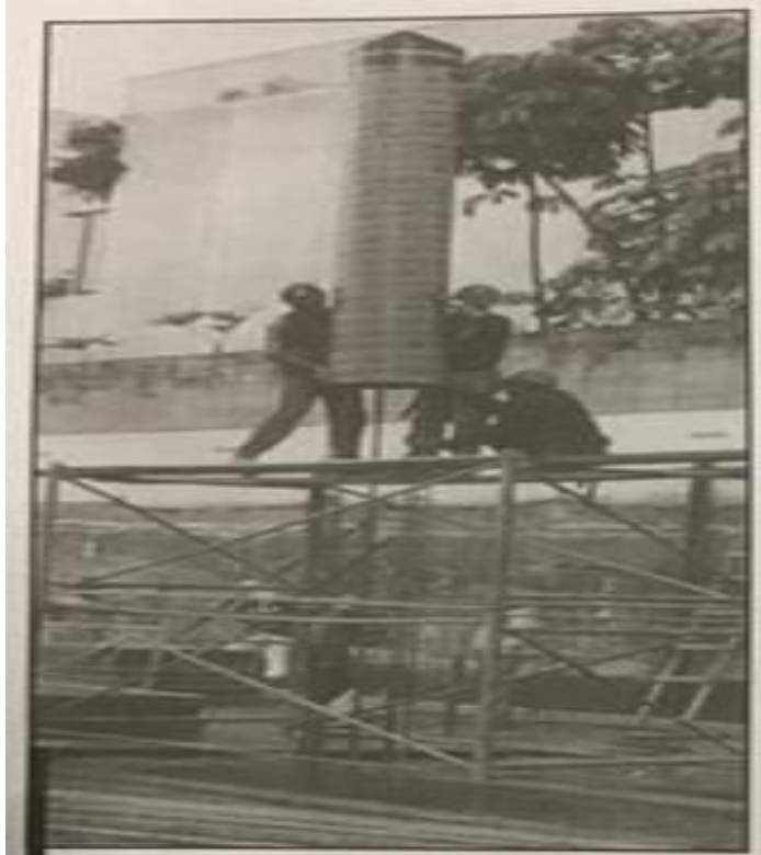
Figura 21 – Fôrmas de papelão para pilares
