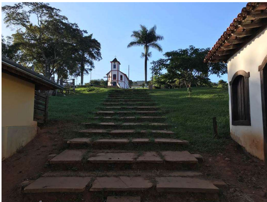
Figura 26: Escadaria de Acesso ao Adro da Capela do Sagrado Coração de Jesus. Fonte: Acervo do Autor, 2022.
