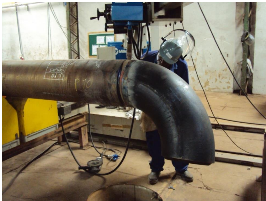
Figura 24 - Processo de soldagem SAW Fonte: Milplan Engenharia
