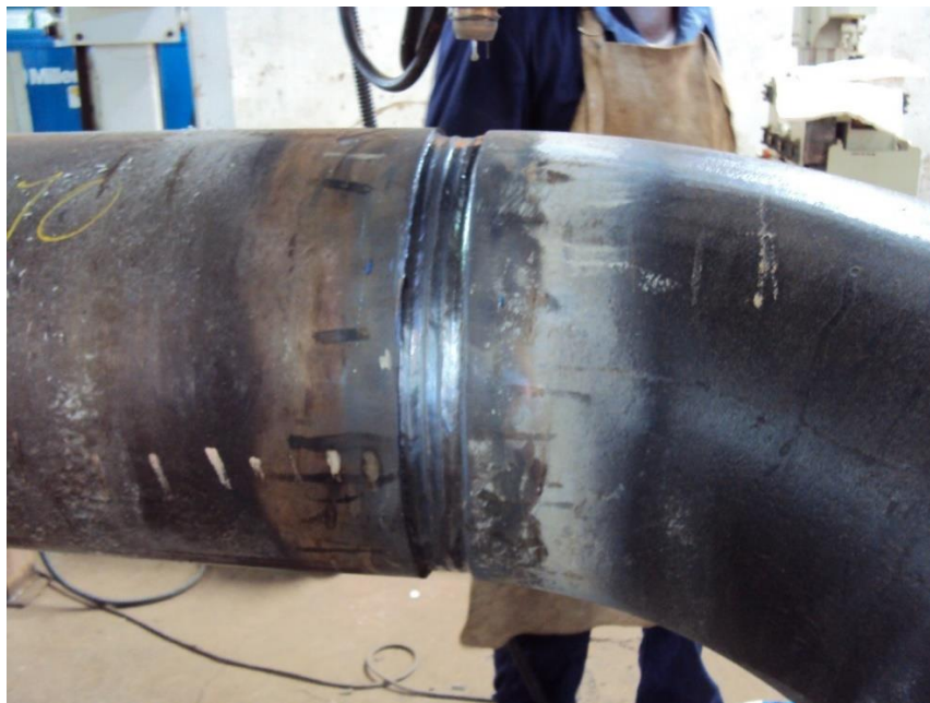
Figura 25 - Solda de enchimento pelo processo SAW Fonte: Milplan Engenharia
