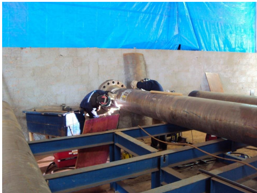
Figura 15 - Soldagem pelo processo GTAW, passe de raiz Fonte: Milplan Engenharia
