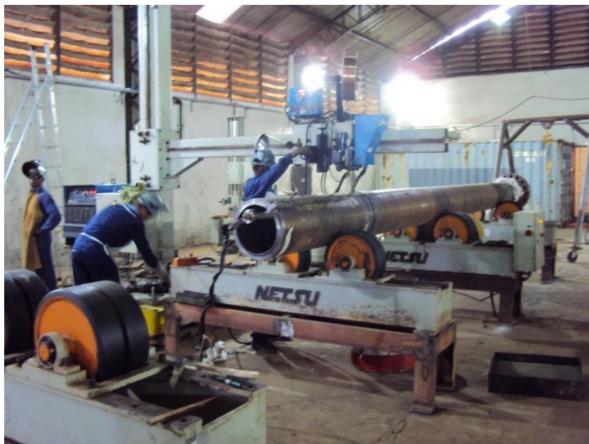
Figura 22 - Processo de soldagem SAW Fonte: Milplan Engenharia
