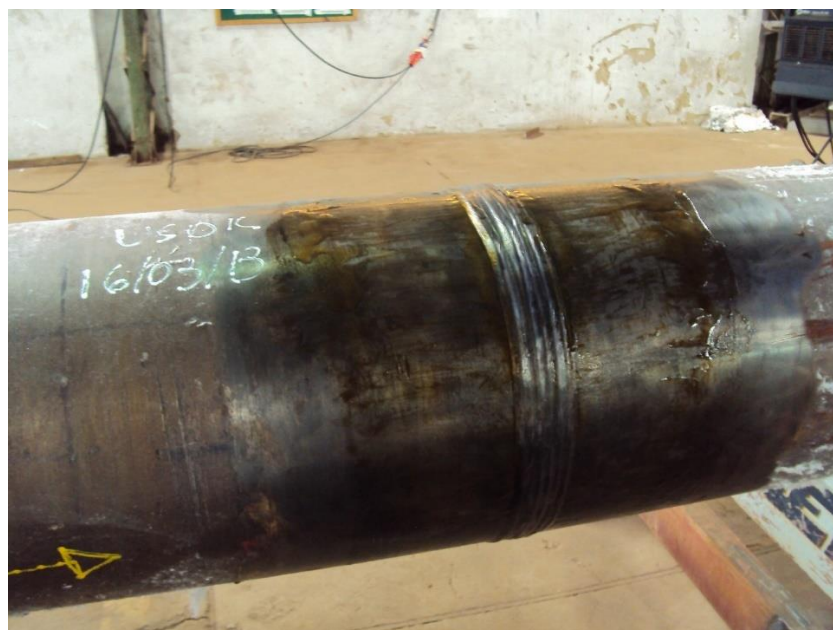
Figura 26 - Solda pelo processo SAW finalizada, com ensaio de ultrassom aprovado Fonte: Milplan Engenharia
