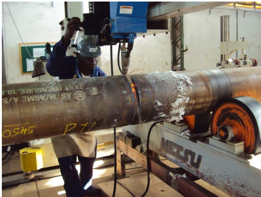
Figura 23 - Processo de soldagem SAW Fonte: Milplan Engenharia
