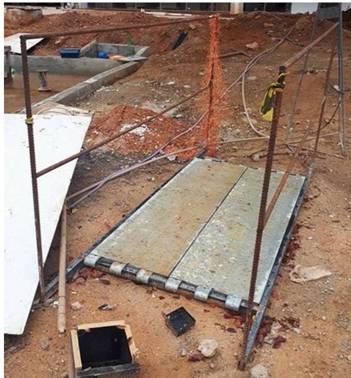
Figura 18 – Mini-passarela usada durante a abertura de valas
