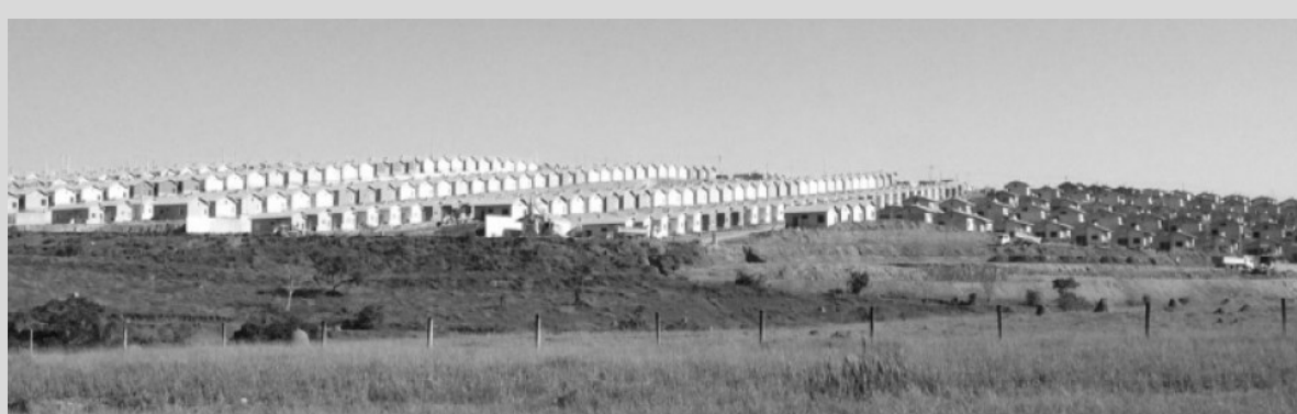
Vista do conjunto Pinheirinho dos Palmares em construção
