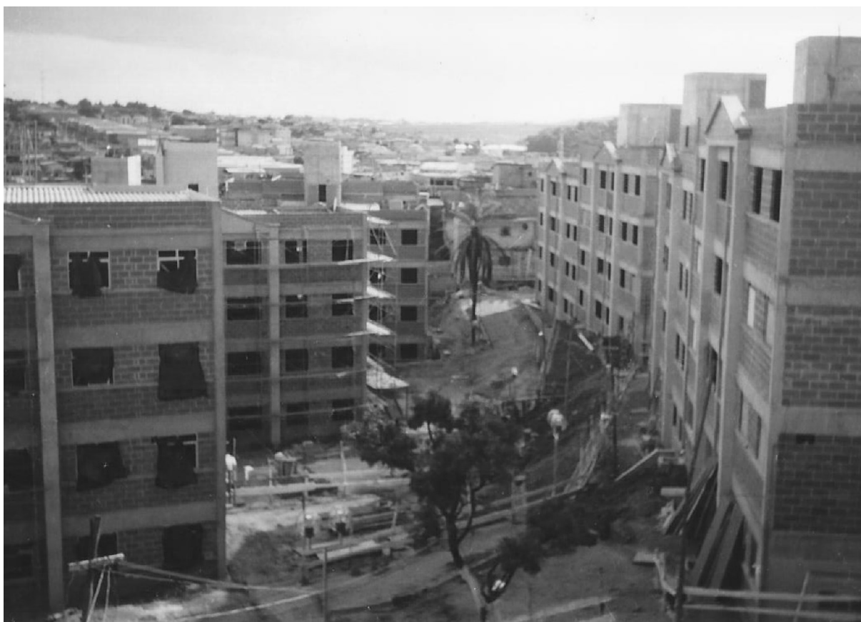
Imagem 12 – Conjunto Serrano (em fase final de obra)
