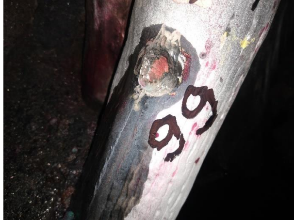
Figura 40 – Reação do aço carbono ao sulfato de cobre de tubo com weld overlay ferrítico em um tubo da abertura de uma canaleta de smelt durante reparo.
