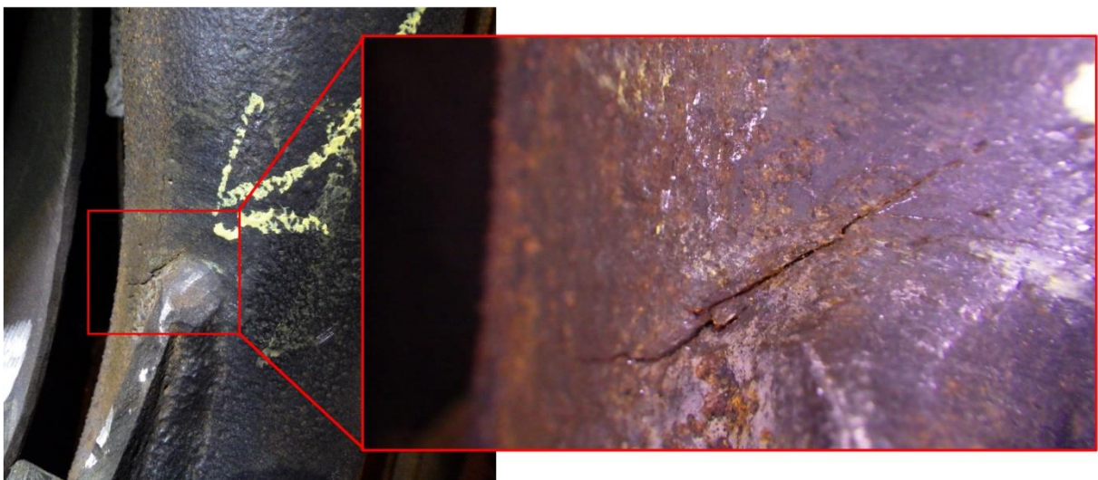
Figura 30 - Trinca de corrosão fadiga junto a aleta em tubo curvado de abertura de soprador de fuligem de uma caldeira de recuperação.
