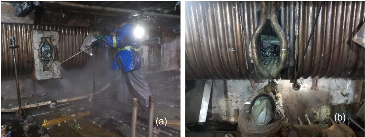
Figura 52 - (a) Remoção de refratário na abertura de uma canaleta de smelt . (a) Início da atividade e (b) término da atividade.
