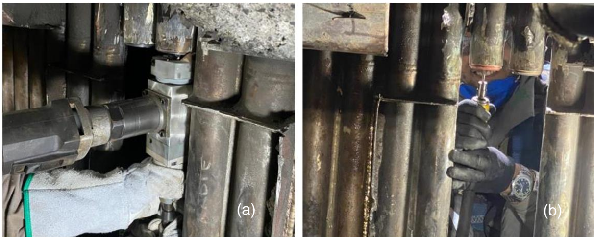
Figura 53 - Preparação do bisel em tubo composto com (a) biseladeira e (b) ajuste do bisel e remoção de pontos contaminados.
