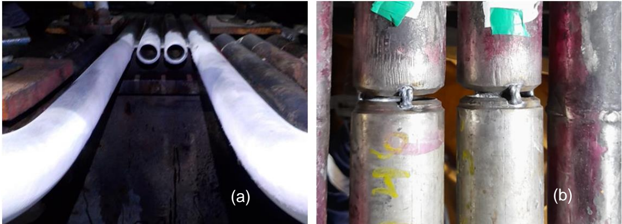
Figura 54 - (a) LP nos flancos e (b) ponteamento dos tubos.
