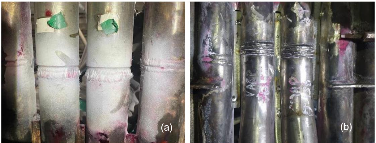
Figura 55 - (a) Soldagem de enchimento concluída e inspecionada por LP e (b) solda de revestimento concluída e montagem ponteamento das aletas.
