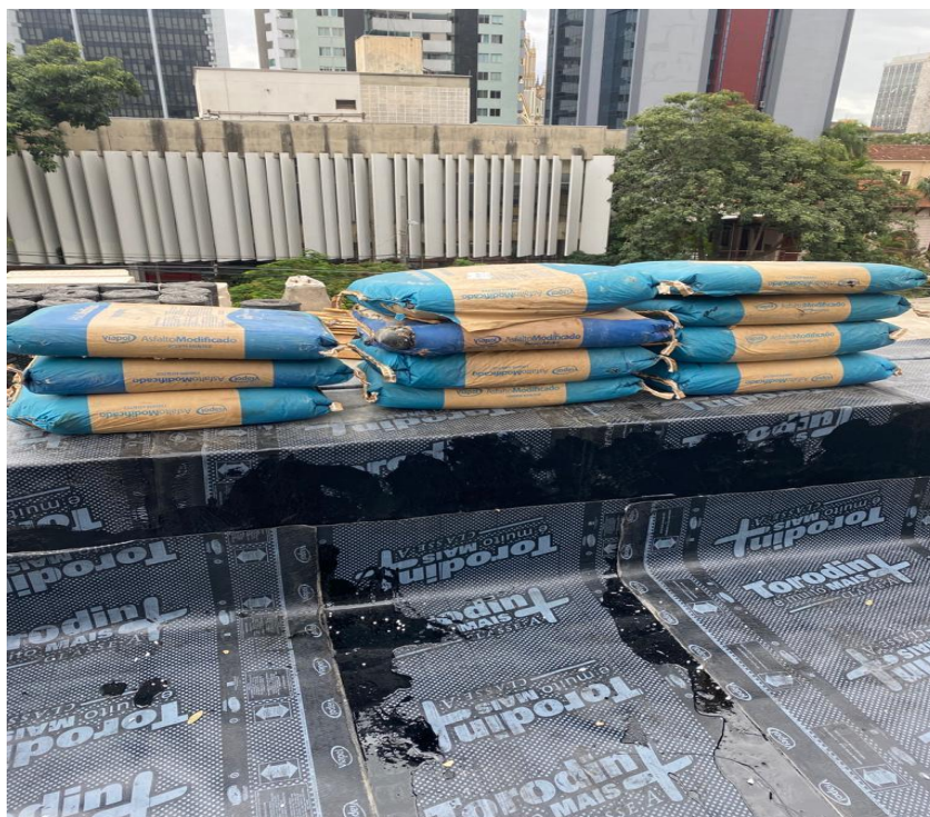
FIGURA 7 – Material em obra e atividade em andamento após replanejamento.
