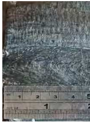
Figura 13. Aspecto exterior del cordón de soldadura - Prueba 1
