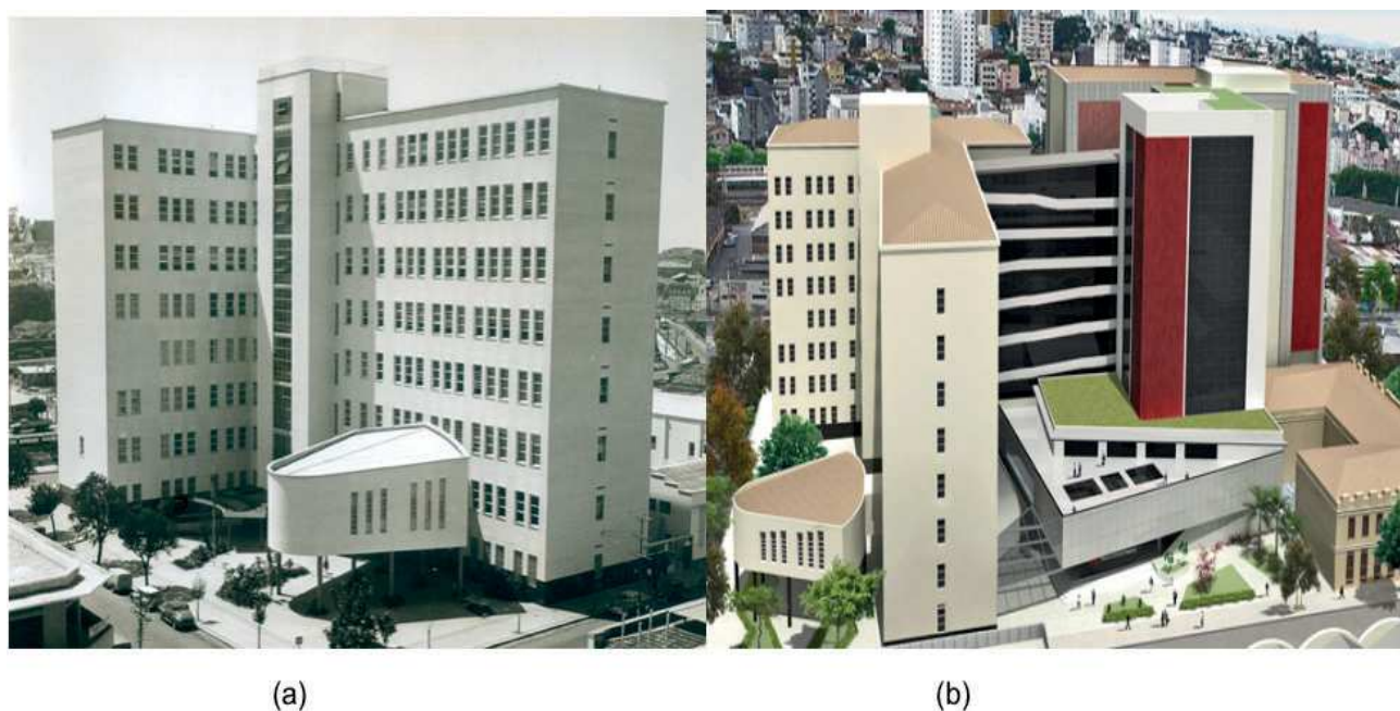
Figura 2 – Obra da antiga Escola de Engenharia da UFMG:
