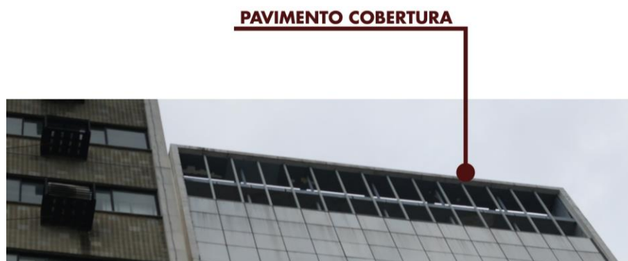
Figura 176 - Pavimento Cobertura do Banco do Brasil (1964).
