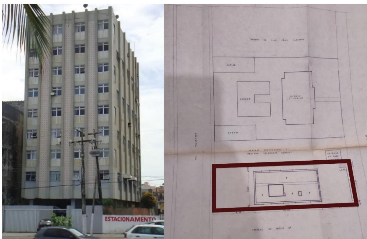
Figura 191 - Edifício Núbia (1967) e sua implantação.
