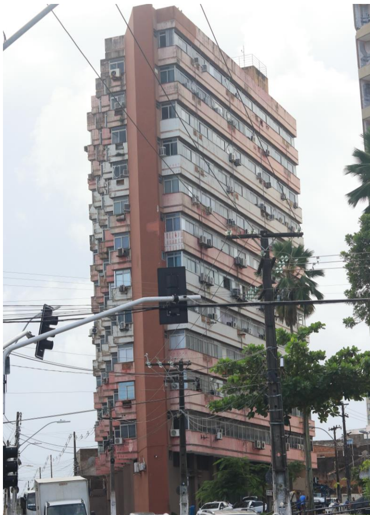
Figura 115 - Edifício Delmiro Gouveia (1977) atualmente.
