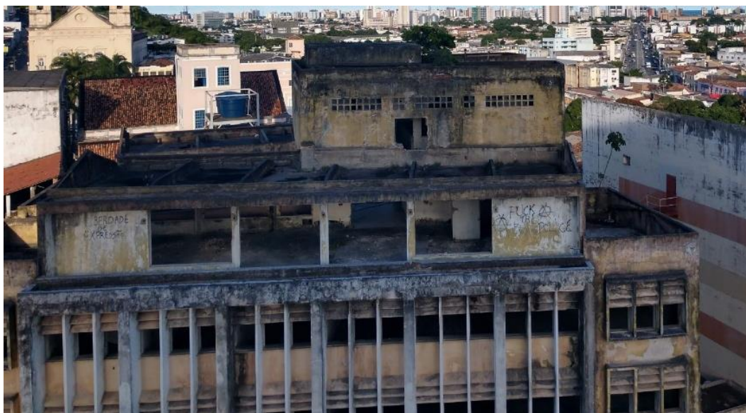
Figura 167 - Pavimento Coberto do IAPTEC (1948).
