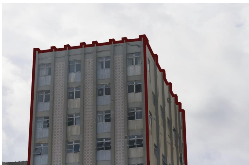
Figura 189 - Fachadas do Edifício Núbia (1967).
