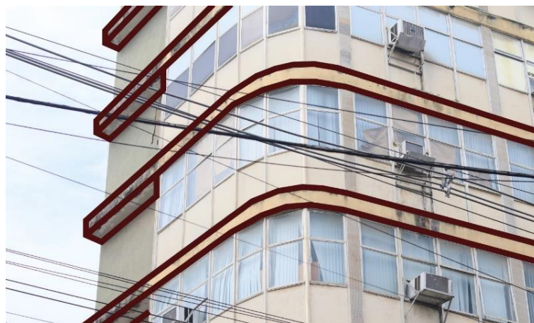
Figura 200 - Fachada dos pavimentos superiores.
