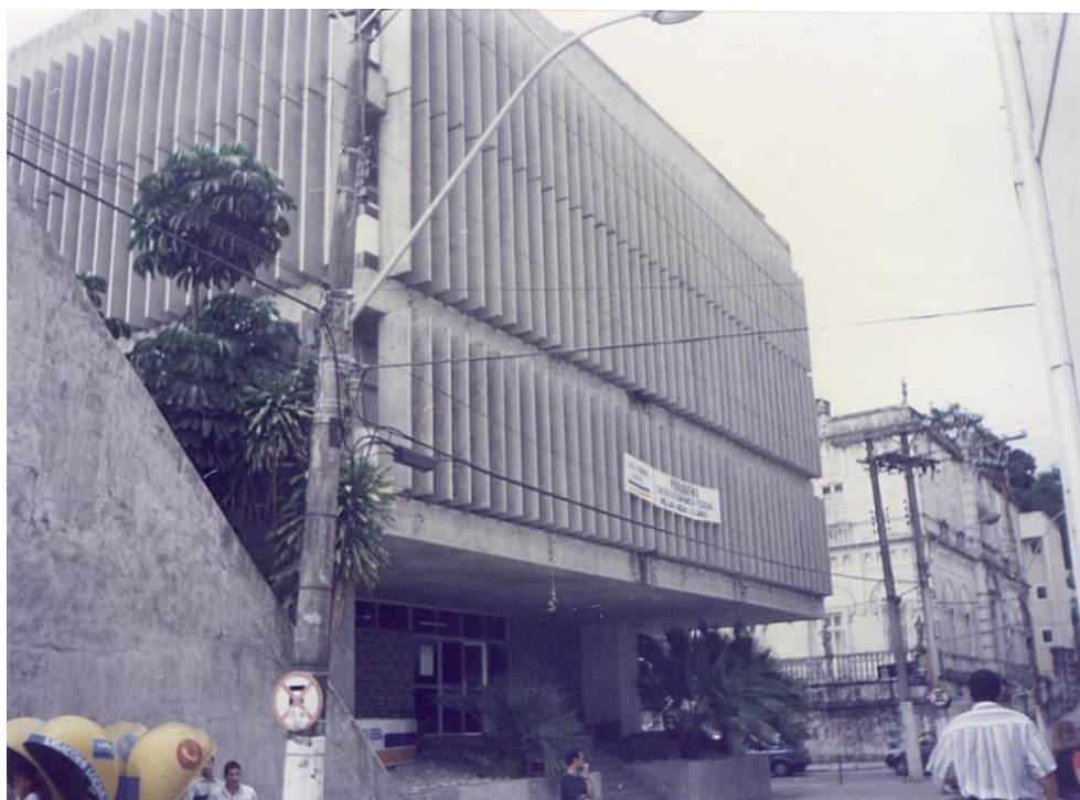
Figura 127 - Agência da Caixa Econômica Federal (1983).
