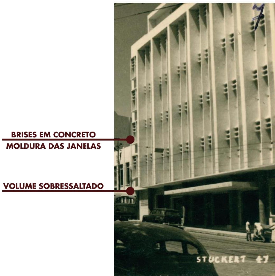
Figura 166 - Detalhes da fachada.
