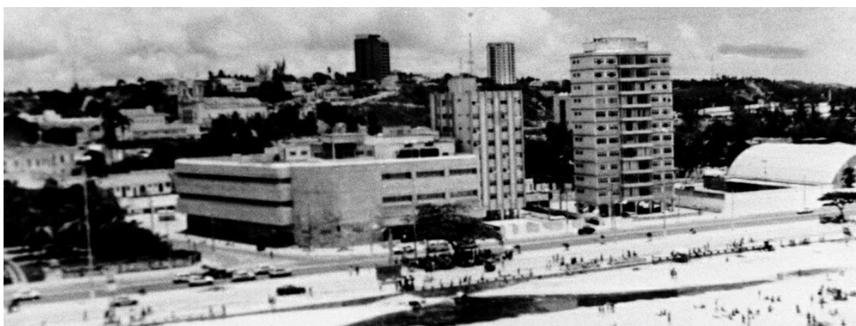
Figura 130 - Lojas Americanas (1983), edificação de esquina.
