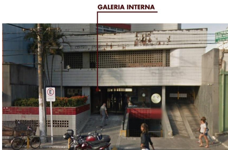
Figura 222 - Galeria interna do Barão de Penedo (1988).
