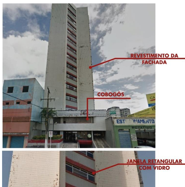
Figura 220 - Aberturas e Revestimento das Fachadas.
