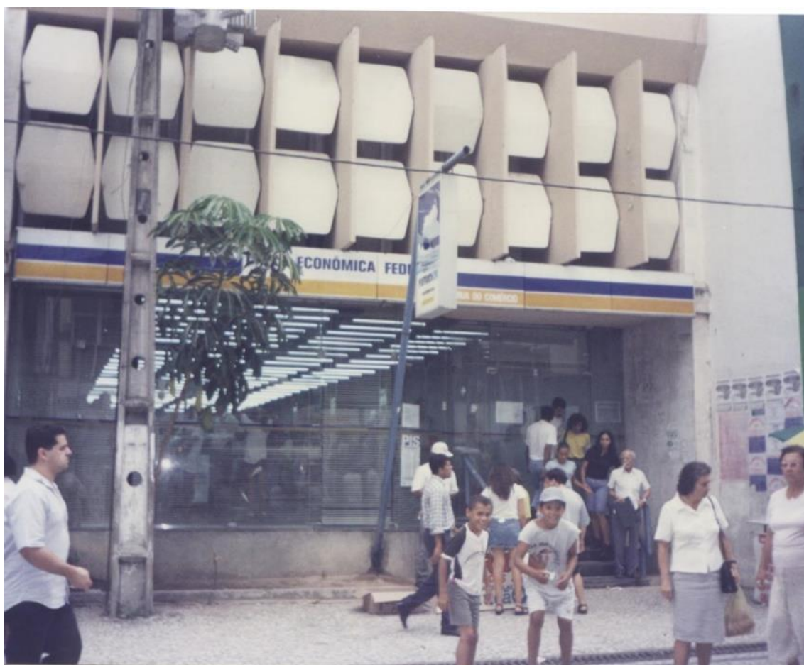
Figura 106 - Agência da Caixa Econômica Federal (1973).
