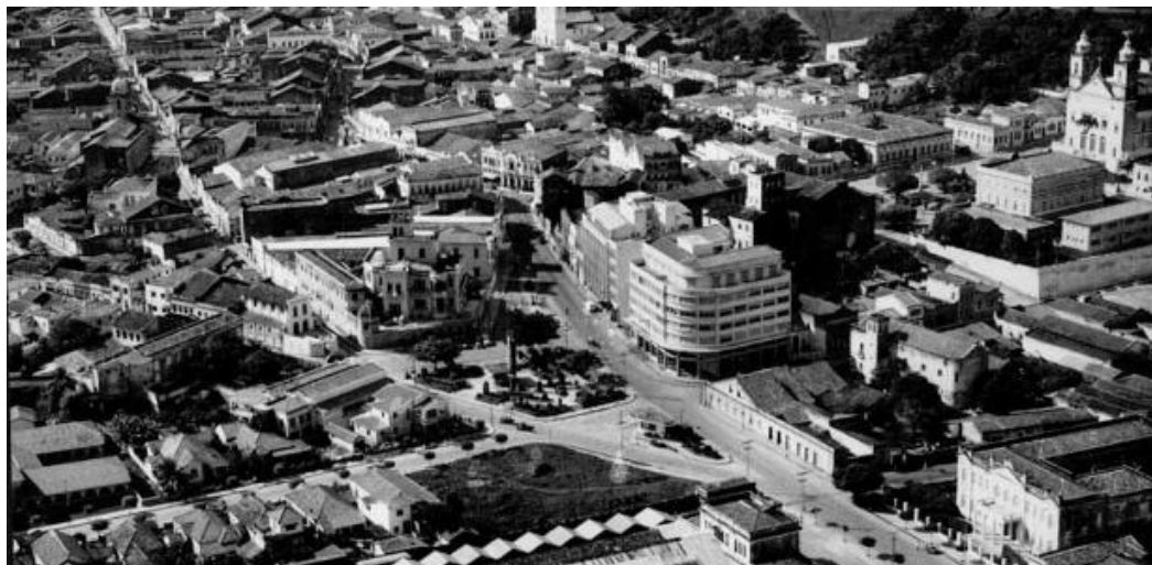
Figura 56 - Vista aérea do Centro de Maceió, ao centro Praça dos Palmeares, ao lado direito, as sedes do IPASE-AL (1947) e IAPETEC (1948) e à esquerda o Hotel Bella Vista, década de 1940.
