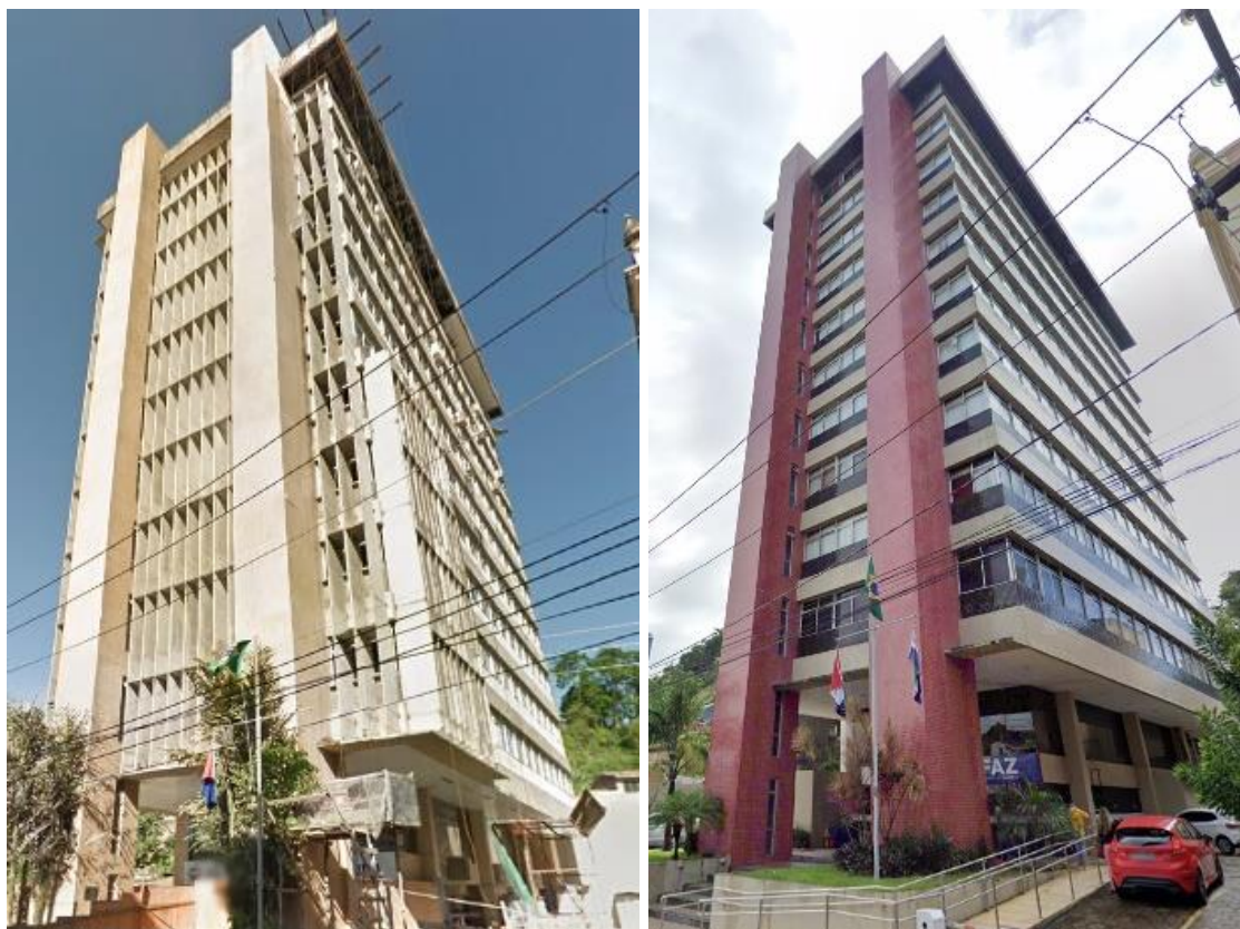
Figura 131 - Secretaria da Fazenda (1981) antes e depois da reforma.
