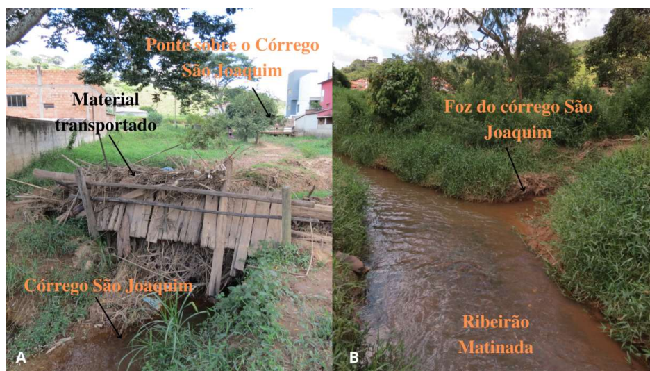
Figura 34- Material transportado no córrego São Joaquim após enchente (A) e Foz do córrego São Joaquim (B)
