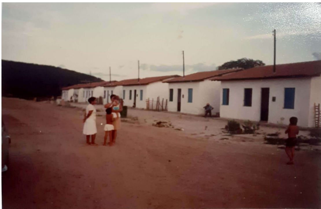
Figura 33 - Casas construídas pela CHESF para os indígenas 1987
