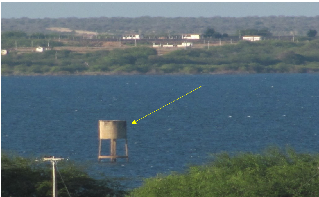
Figura 68 - Caixa d’água que restou da Velha Rodelas – Bahia
