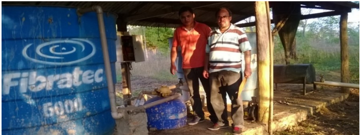
Figura 15 - Área de funcionamento da bomba de água.
