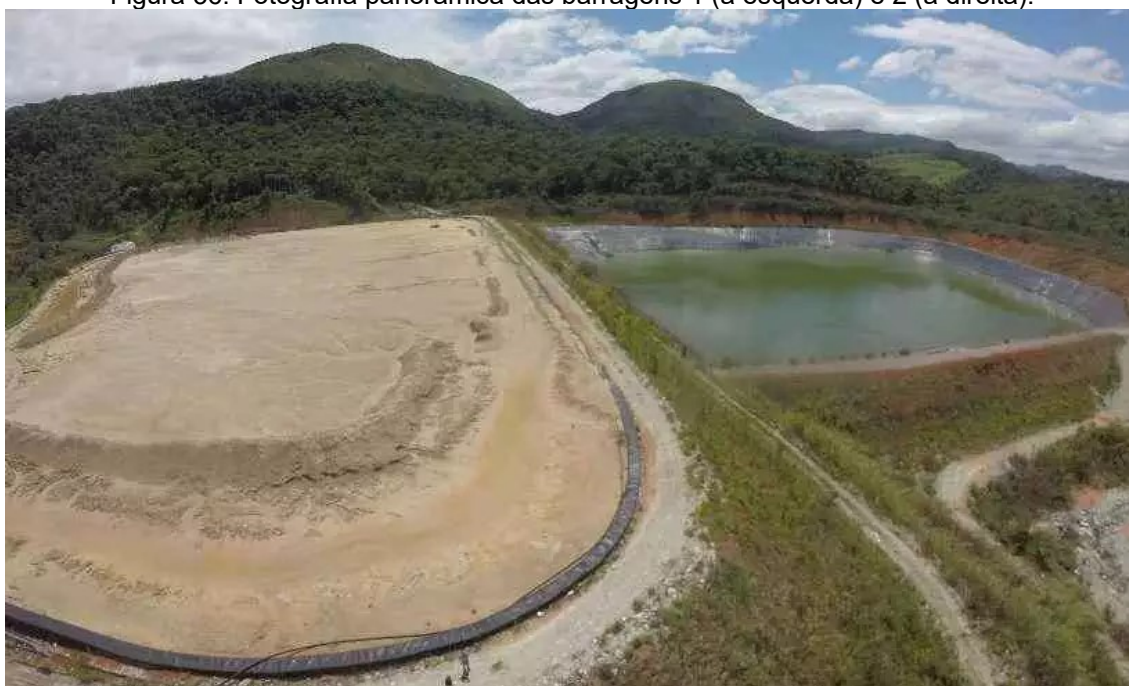
Figura 36: Fotografia panorâmica das barragens 1 (à esquerda) e 2 (à direita).
