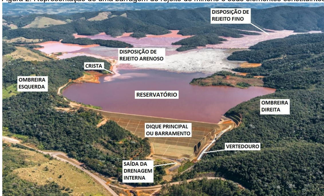
Figura 2: Representação de uma barragem de rejeito de minério e seus elementos constituintes.
