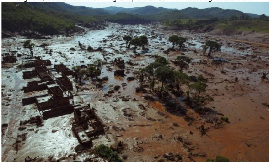
Figura 26: Distrito de Bento Rodrigues após o rompimento da barragem de Fundão.
