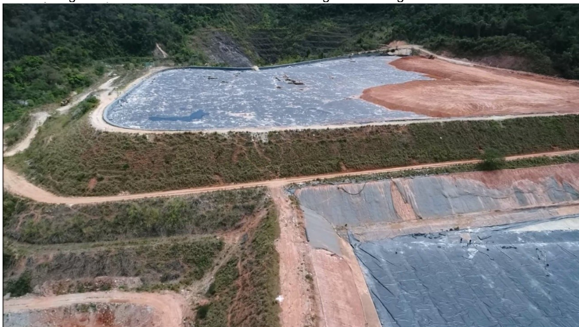
Figura 38: Obras de revestimento das barragens com a geomembrana PEAD.
