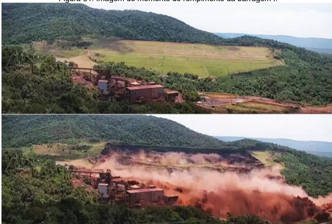
Figura 31: Imagem do momento do rompimento da barragem I.
