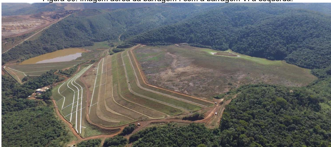
Figura 30: Imagem aérea da barragem I com a barragem VI à esquerda.
