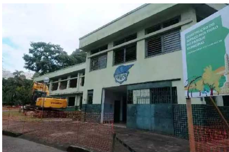
Figura 67: Colégio IMACO em fase de demolição
