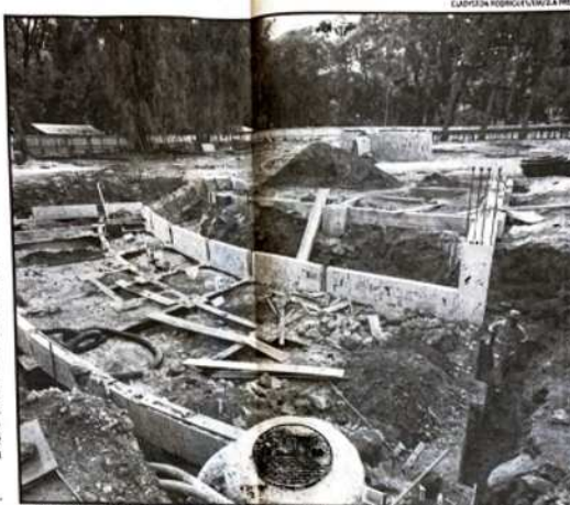
Apenas cinco operários trabalham na obra do Espaço Multiuso. No início, eram 40 funcionários contratados
