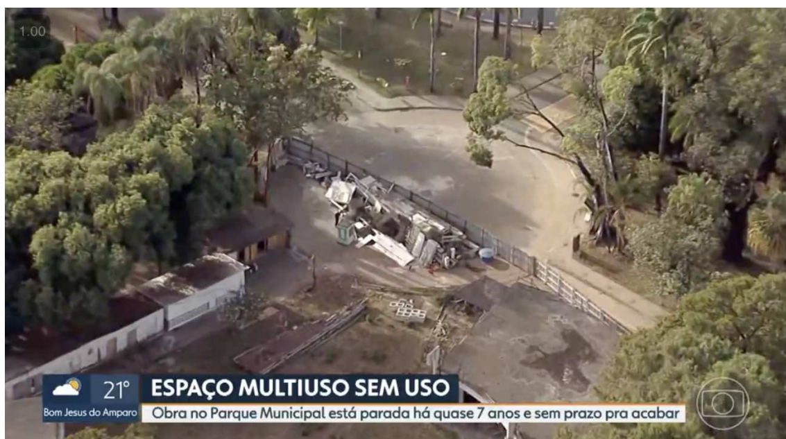
Figura 78: Imagens aéreas do "Espaço Multiuso" inacabado - 2/2
