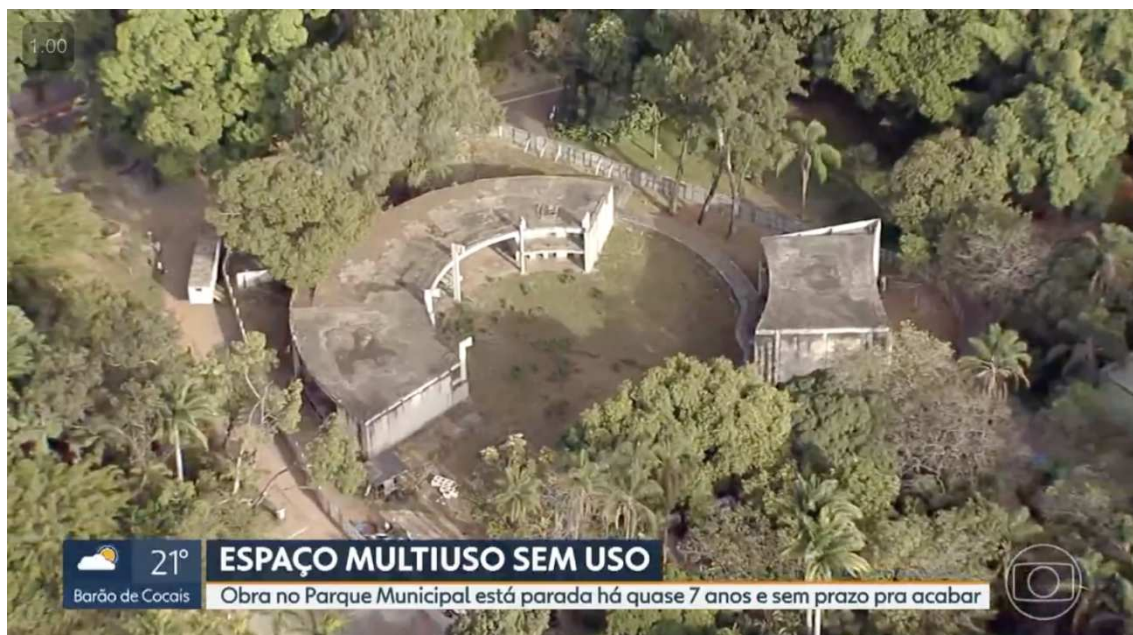
Figura 77: Imagens aéreas do "Espaço Multiuso" inacabado - 1/2
