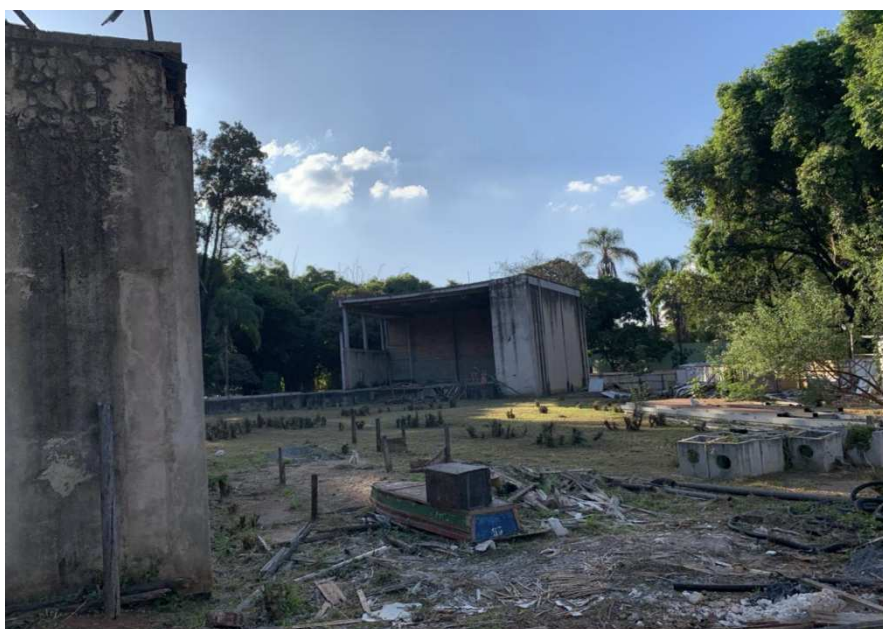
Figura 79: Imagens atuais das obras do "Espaço Multiuso" - 1/2
