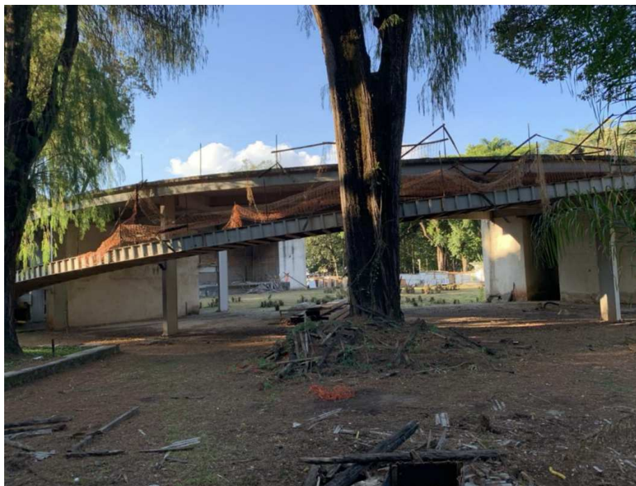
Figura 80: Imagens atuais das obras do "Espaço Multiuso" - 2/2
