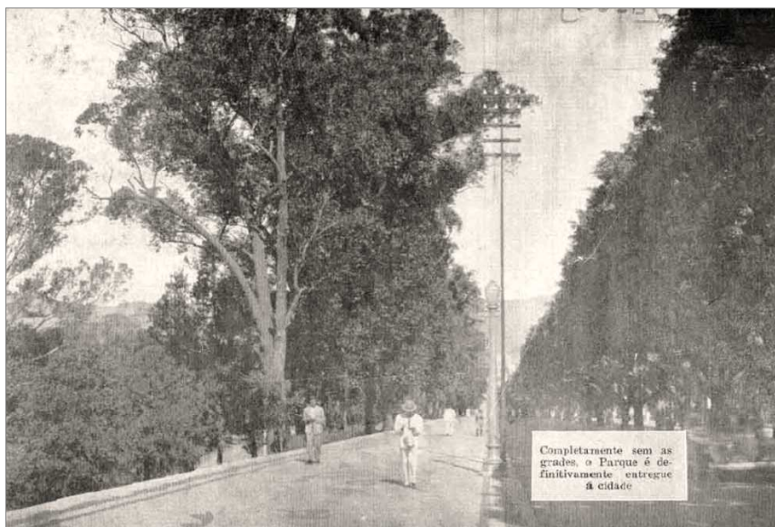
Figura 19: Parque Municipal após a retirada das grades
