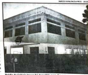
Prédio do Colégio Imaco foi demolido para dar espaço a obras
