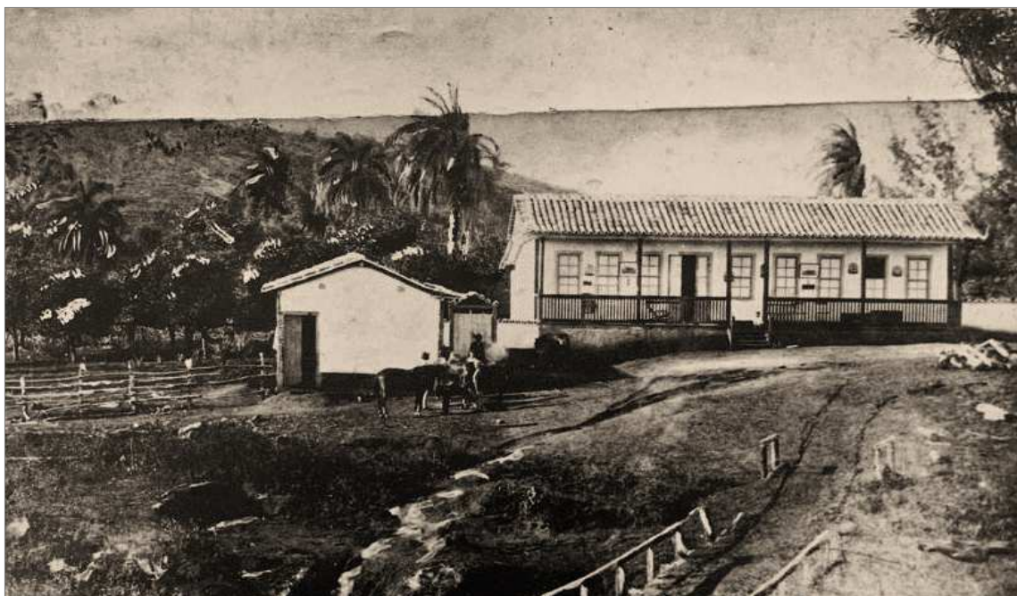
Figura 8: Casa da "Chácara do Sapo" que serviu de residência à Comissão Construtora
