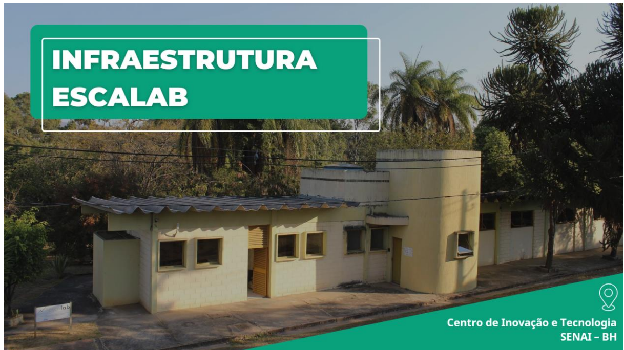
Figura 6 – Infraestrutura do Escalab no Centro de Inovação e Tecnologia SENAI - BH.
