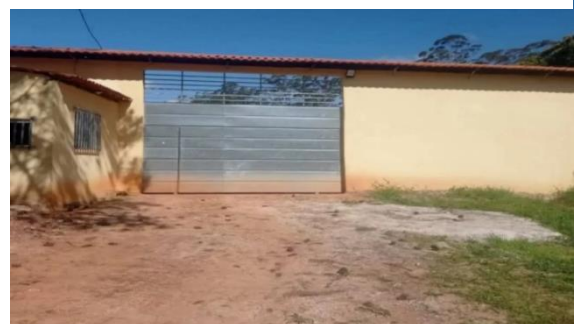
Figura 33 - Entrada de condomínio construído em ARPM, São Paulo.
