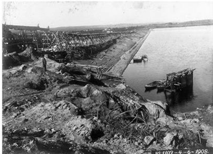
Figura 5 - Vista da barragem Guarapiranga em construção a partir da encosta da margem esquerda
