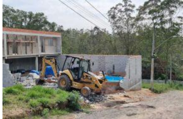
Figura 34 - Demolição de construção irregular na região de Parelheiros, São Paulo (2023)
