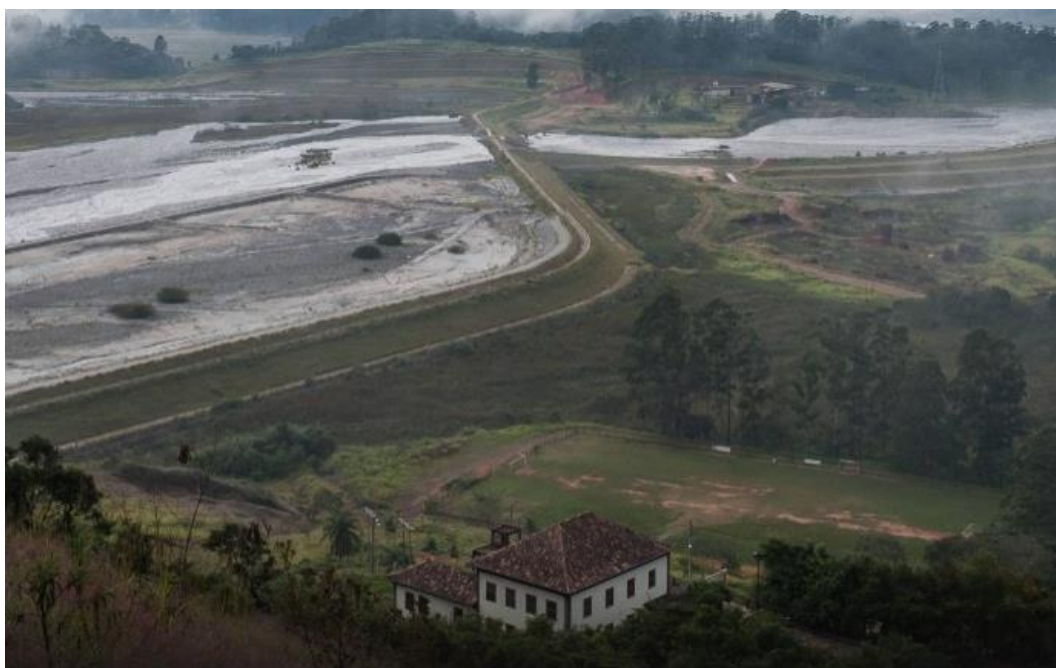
Figura 24: Vista do novo sítio, localizado em frente a barragem de rejeitos de mineração da empresa Vale S.A.
