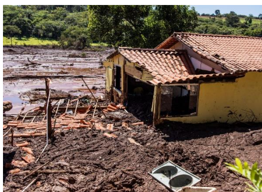
Figura 87: Área destruída pela passagem da lama de rejeitos.
