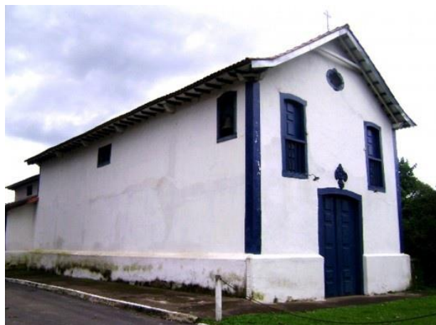
Figura 79: Capela de São Bento, destruída pelo rejeito da Barragem de Fundão.
