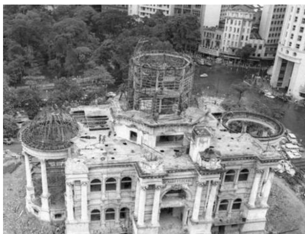
Figura 19: Palácio Monroe, no processo de demolição, em 1976
