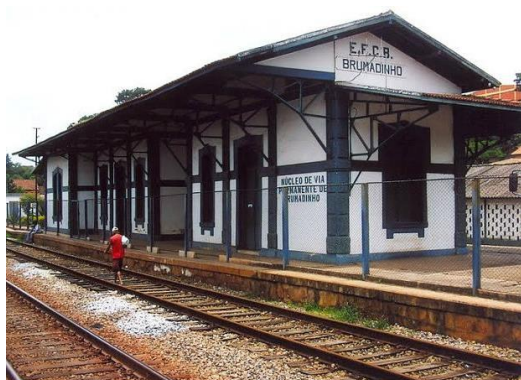
Figura 44: Estação ferroviária de Brumadinho, inaugurada em 1917
