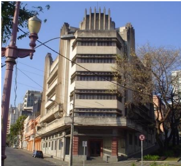
Figura 50: Edifício Chagas Dória, rua Sapucaí, Belo Horizonte, estilo Art Deco
