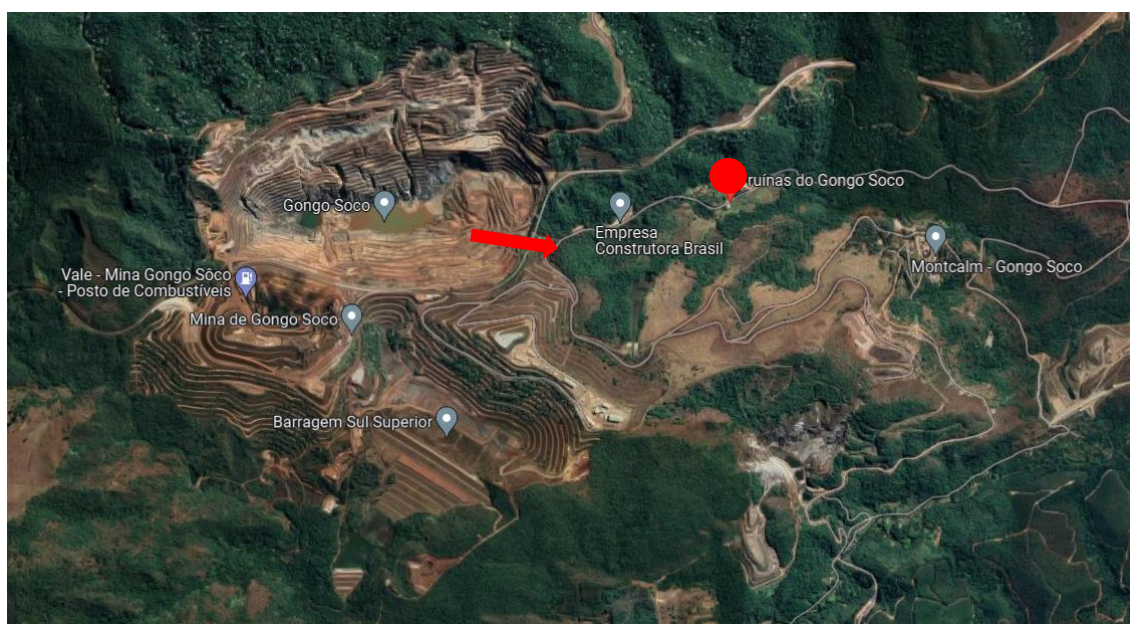
Figura 74: Ruínas de Congo Soco, distrito de Socorro, Barão de Cocais, a aproximadamente 1000m da Mina Congo Soco.
