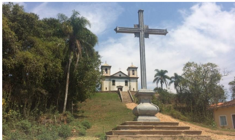
Figura 77: Acesso a Igreja de Nossa Senhora da Conceição feito pelo cruzeiro e escadaria.
