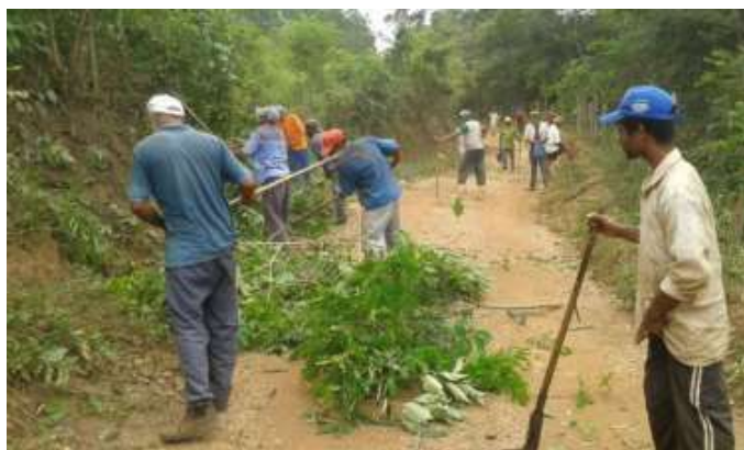
Pais de alunos fazendo a manutenção de estrada usada pelo transporte escolar. Por Maurício T. Mendes (2015).
