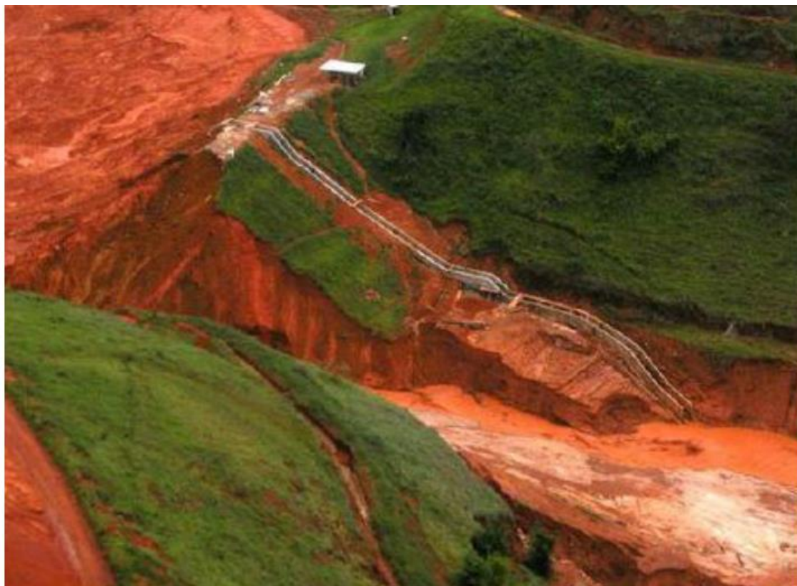
Figura 6 – Imagem lateral do rompimento da barragem São Francisco em Cataguases
