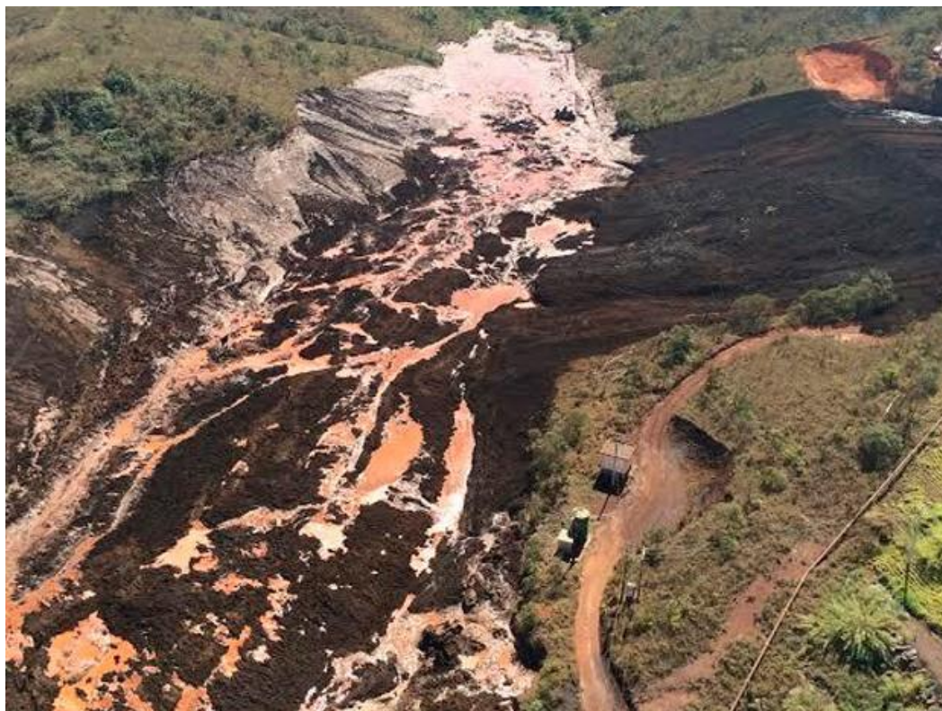
Figura 8 - Destruição causada pelo rompimento da barragem da mina Retiro do Sapecado
