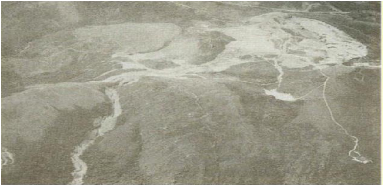
Figura 4 - Vista aérea da barragem de Fernandinho após seu colapso
