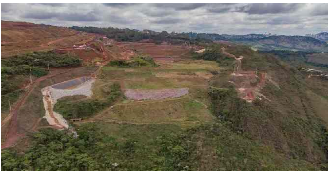
Figura 17 - Vista da barragem B3/B4 localizada em Nova Lima
