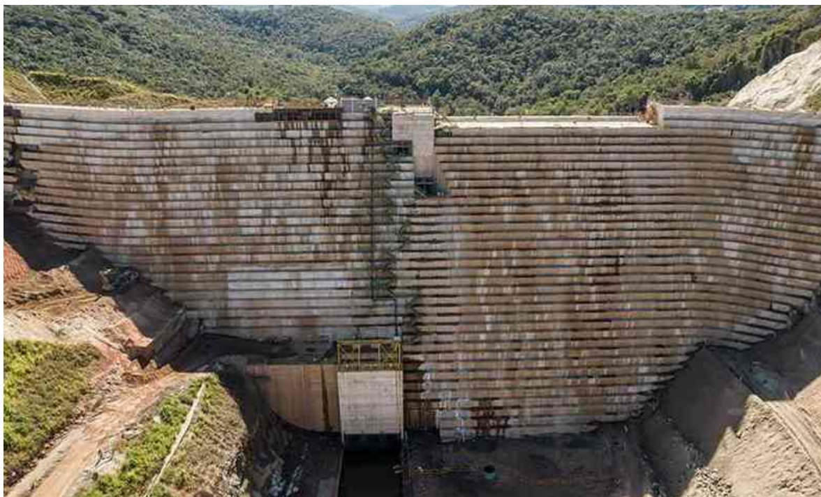
Figura 14 - Barragem construída para conter os rejeitos das barragens de Forquilhas
