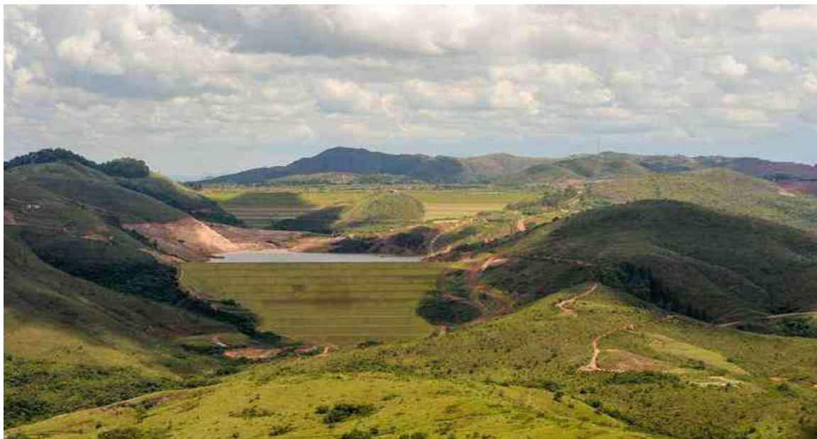
Figura 13 - Visão das barragens de Forquilha I, II, III, e IV
