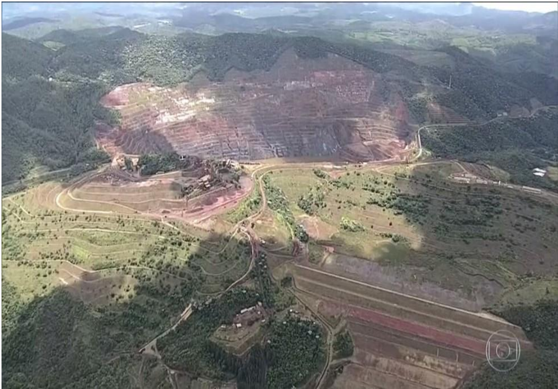
Figura 15 - Barragem de rejeitos Sul Superior na Mina de Gongo Soco
