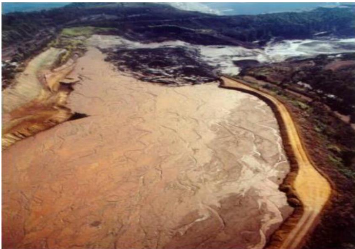
Figura 5 - Vista aérea da barragem C1 após seu rompimento
