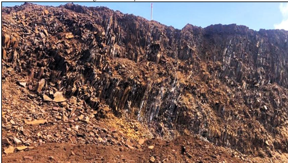
Figura 17 - Maciço altamente estratificado.
