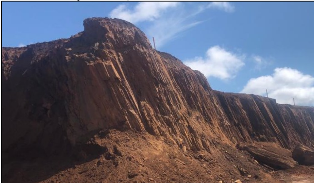
Figura 11 – Maciço rochoso densamente estratificado.
