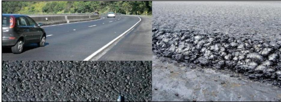
Para Campbell (1999), o SMA possui excelente durabilidade ao desgaste por abrasão em função da baixa permeabilidade, que é proporcionada pelo mástique asfáltico rico em CAP (cimento asfáltico de petróleo). Essas características propiciam um aumento de mais de 20% ao tempo de serviço do SMA, quando comparado às misturas asfálticas convencionais.
